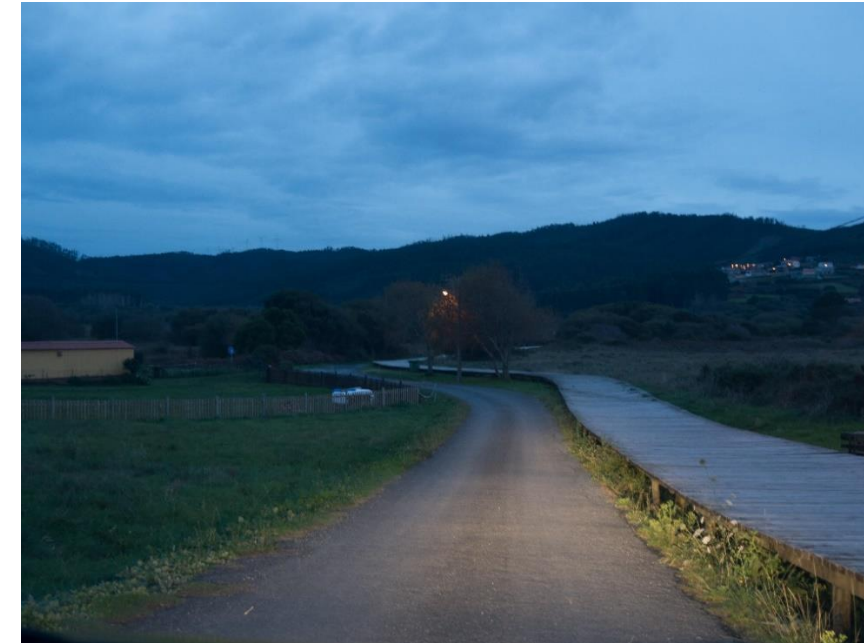
Estado actual del paseo de madera y carretera que unen las dos puntas de la playa. (Tramo inicial)
