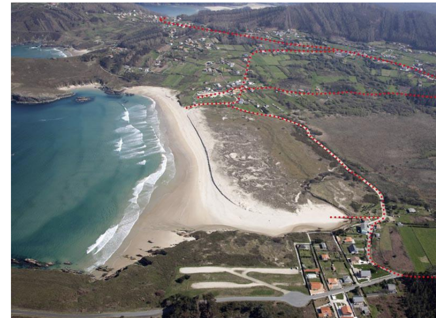
En esta imagen se aprecia el aparcamiento que se encuentra al Oeste de la playa, así como la carretera que une los dos aparcamientos.
