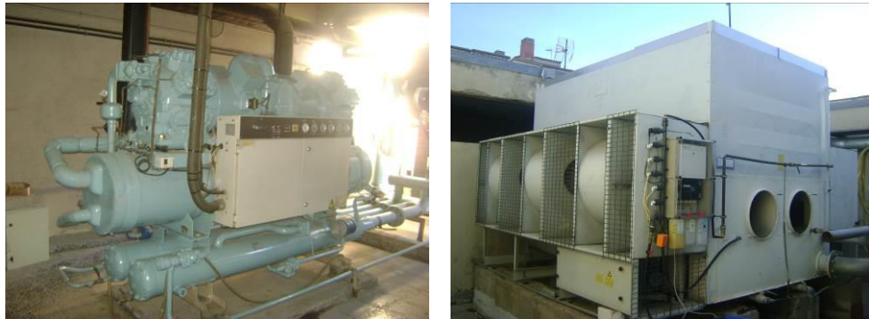
Figura 19: Enfriadora y torre de refrigeración
