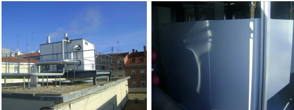
Figura 18: Sala técnica y caldera
