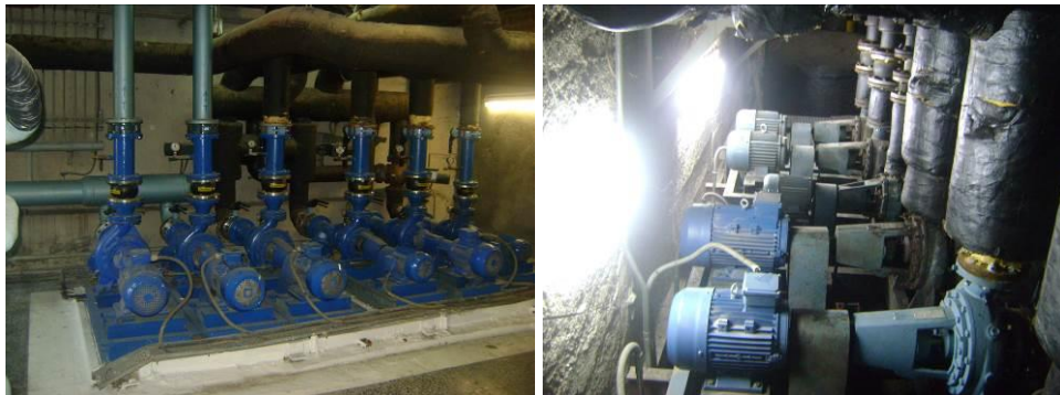
Figura 22: Instalaciones de impulsión y retorno
