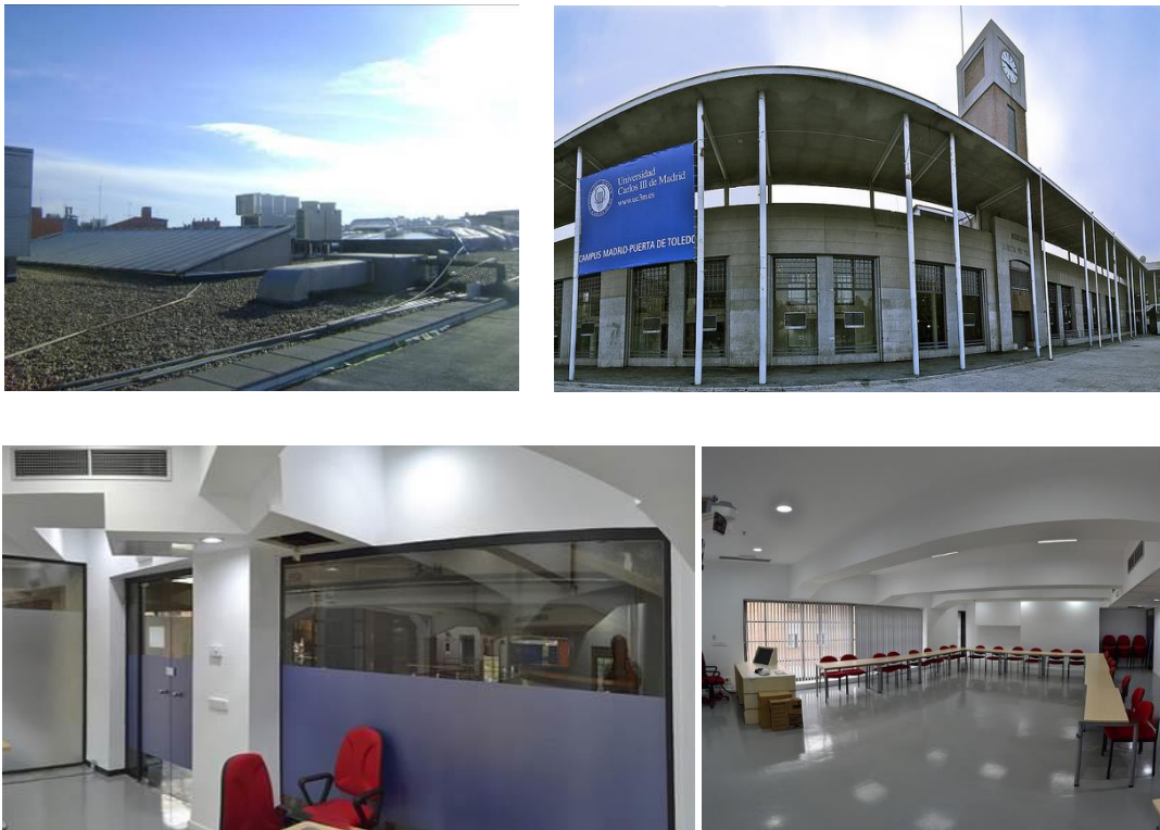
Figura 14: Cubierta, fachada exterior y cerramientos
