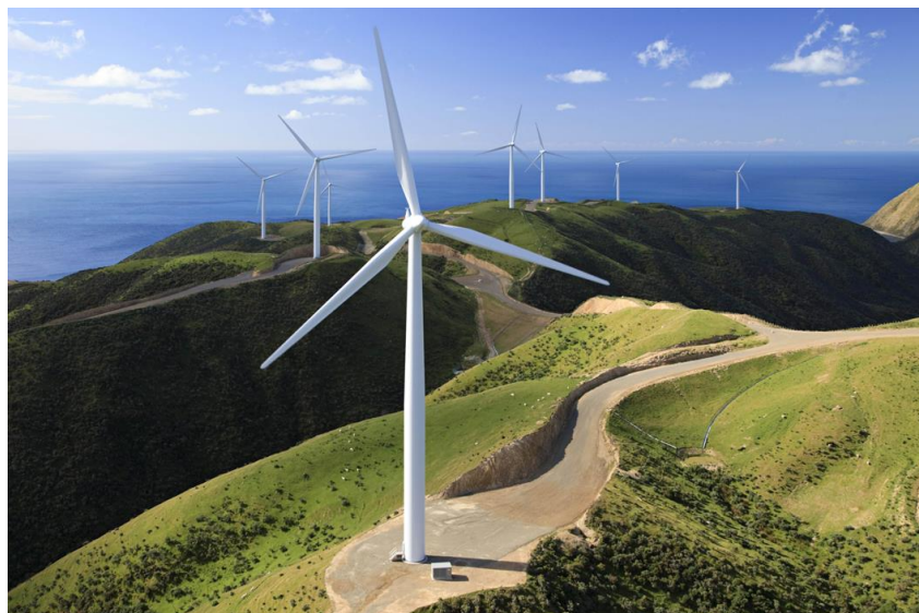
Figura 4. Parque eólico onshore
