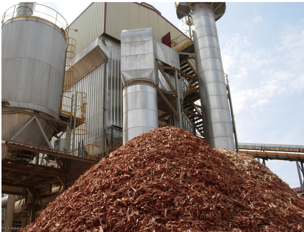
Figura 8: Planta de biomasa en Córdoba, España.
