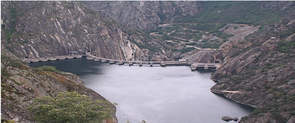
Figura 6: Hidroeléctrica de Aldeadávila, Salamanca
