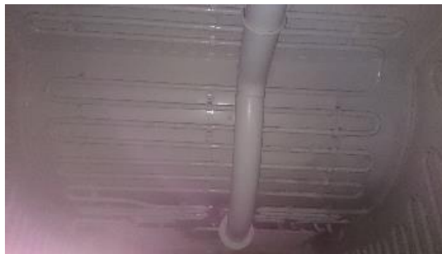
Imagen 62. Serpentines y colector salmuera
