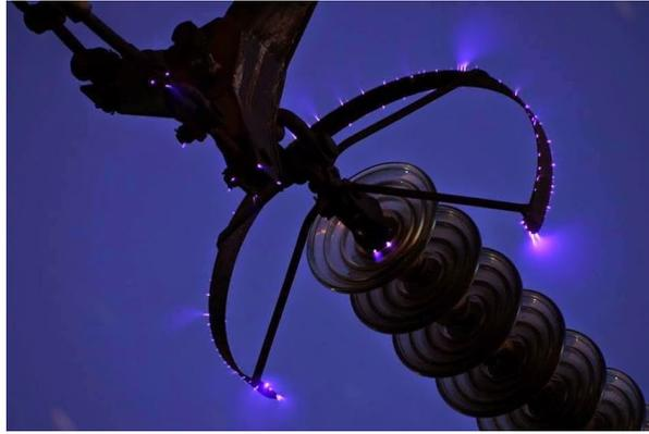
**Figura 13** – Representación efecto Corona en una línea de transporte.
