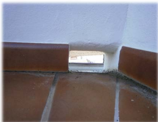
Imaxe 61. Detalle Evacuación de augas Terraza Exterior
