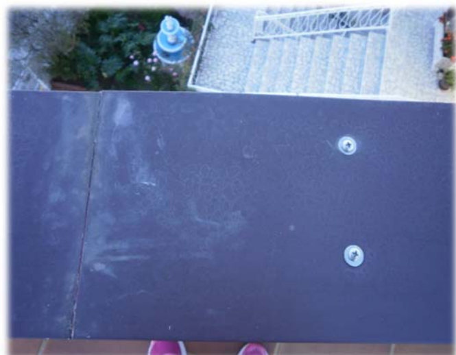
Imaxe 57. Remate perimetral Terraza Exterior
