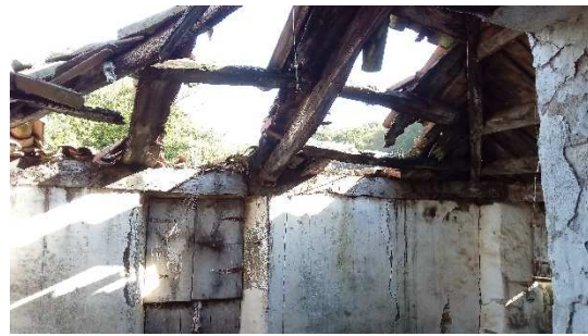
Imagen 21. Techo de la bodega 1
