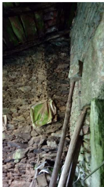
Imagen 23. Entrada trasera por exterior
