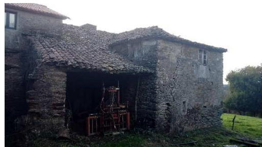
Imagen 4. Fachada Norte entrada trasera
