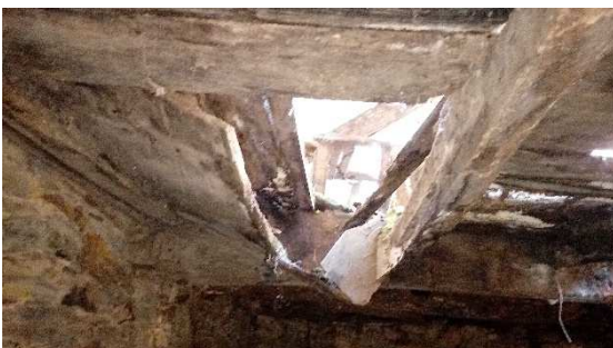
Imagen 25. Techo de la bodega
