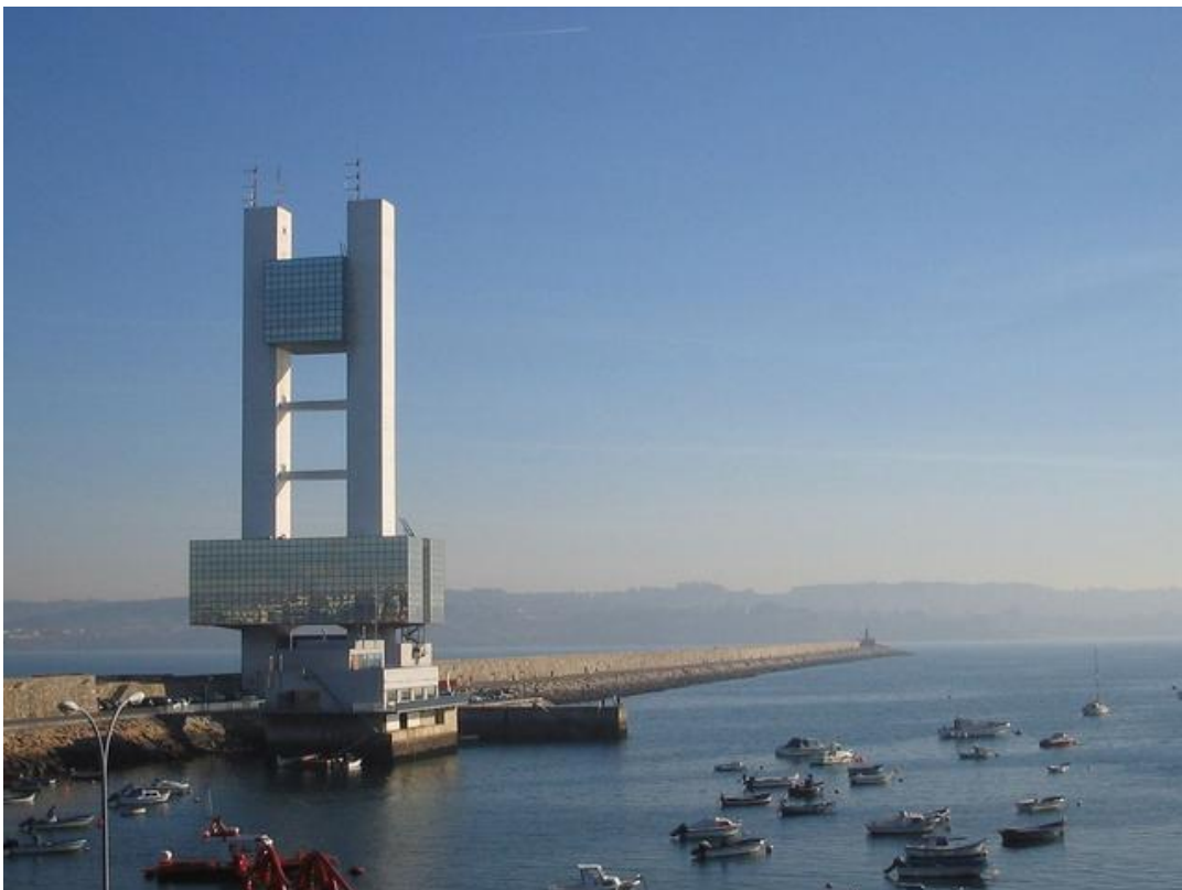
Figura 3.4.7. – Torre de control marítimo da Coruña.
