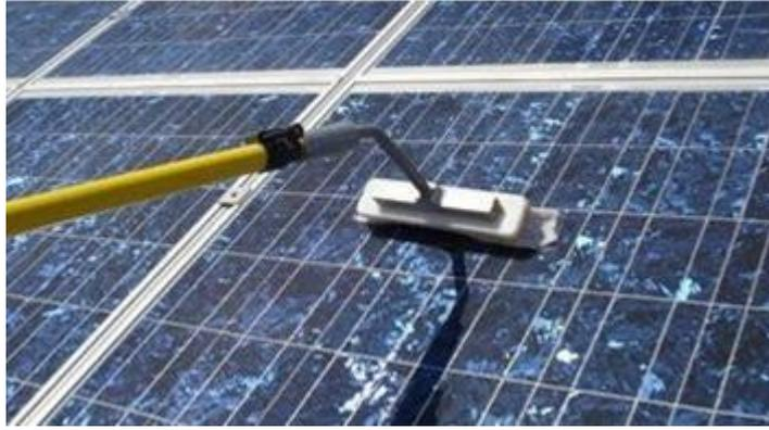
Figura 8.1 – Limpieza de un panel.
