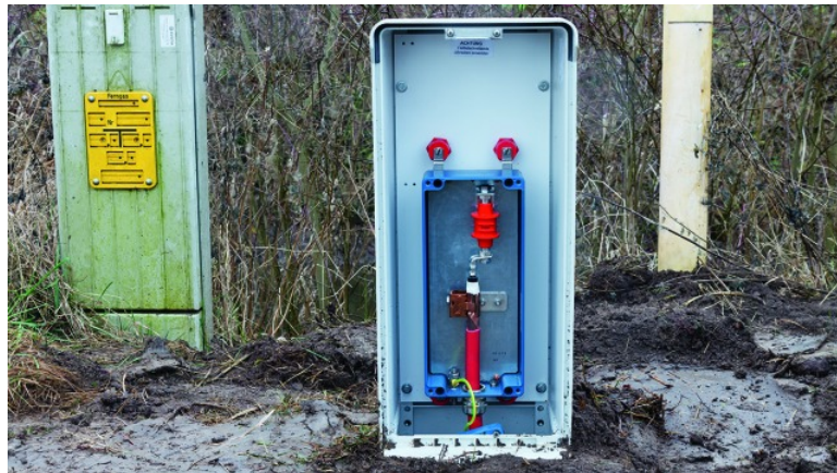
Figura 4.10: Ponte en brida de illamento
