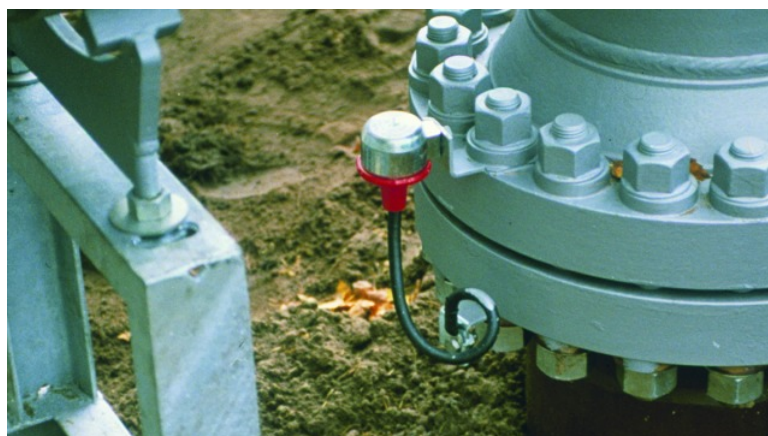
Figura 4.11: Ponte en brida de illamento. Conexión indirecta a toma de terra
