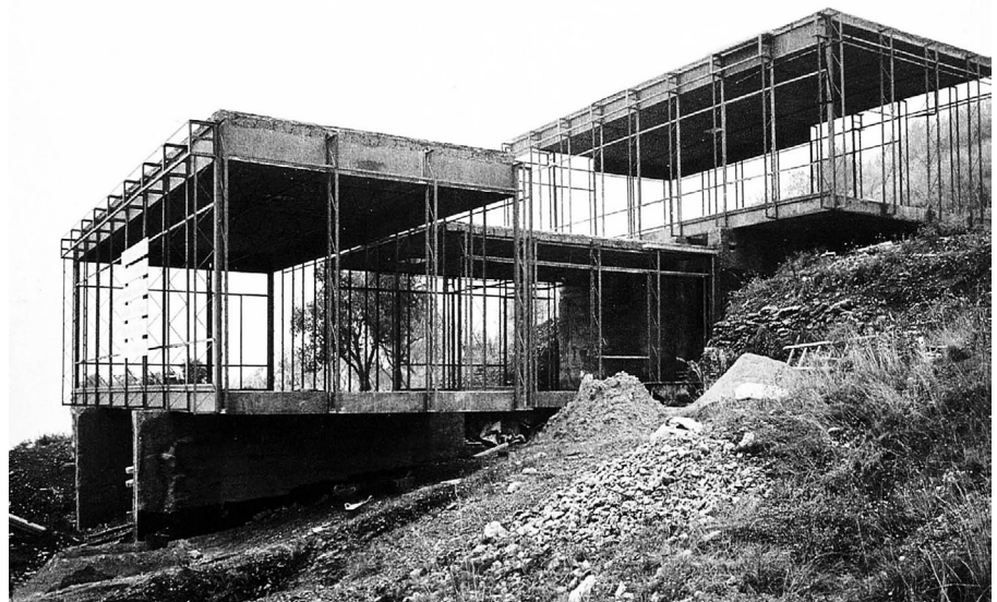
06. Tous y Fargas, Casa Door (1957-1958); Fotografía de la obra abandonada.
