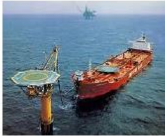
Imagen 32. Terminal offshore de descarga.
