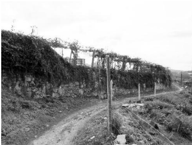
Vista de la muro en bancal al sur de la parcela y camino de servidumbre de acceso a la parcela
