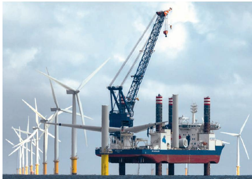
Figura 3.4.1.1: Sea Installer trabajando.
