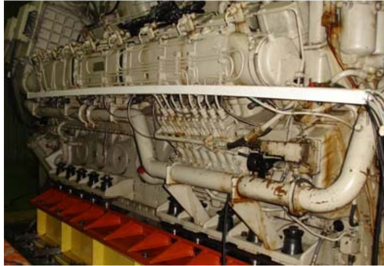
Foto 4. Canalización por la que se conducen las líneas de los sensores de presión.
