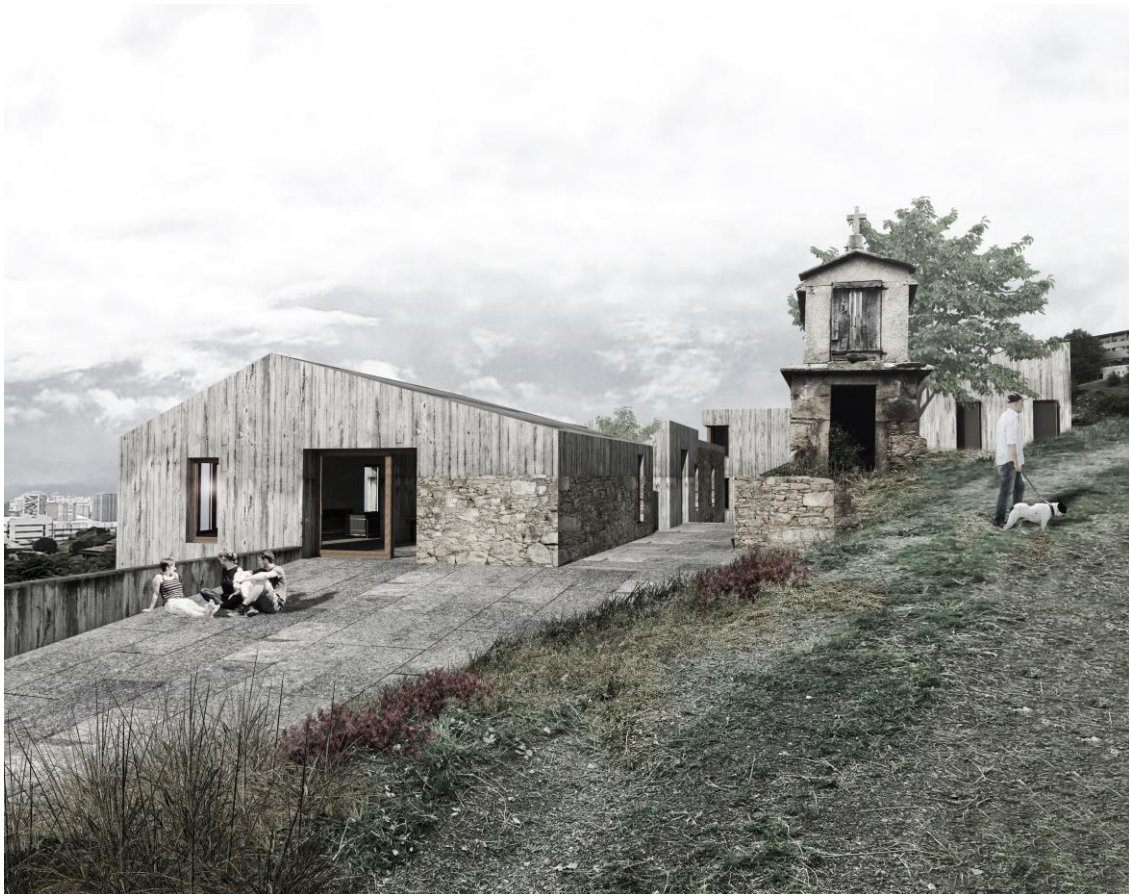
Recorrido posterior, ruina y espacio previo
