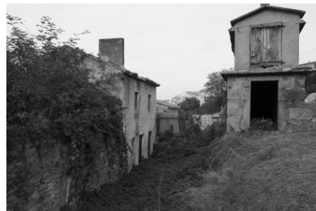
Recorrido posterior. Estado actual
