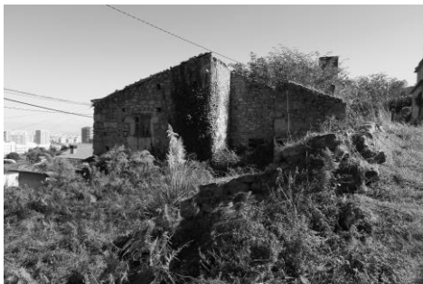
Ruina y espacio exterior. Estado actual
