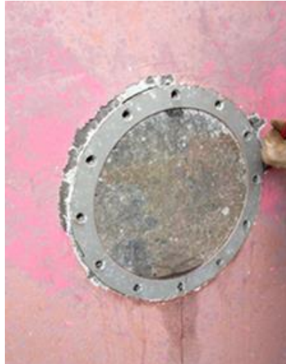
Ilustración 52-Colocación ánodo de inyección 1
