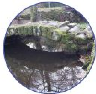
Puente de Paradela
