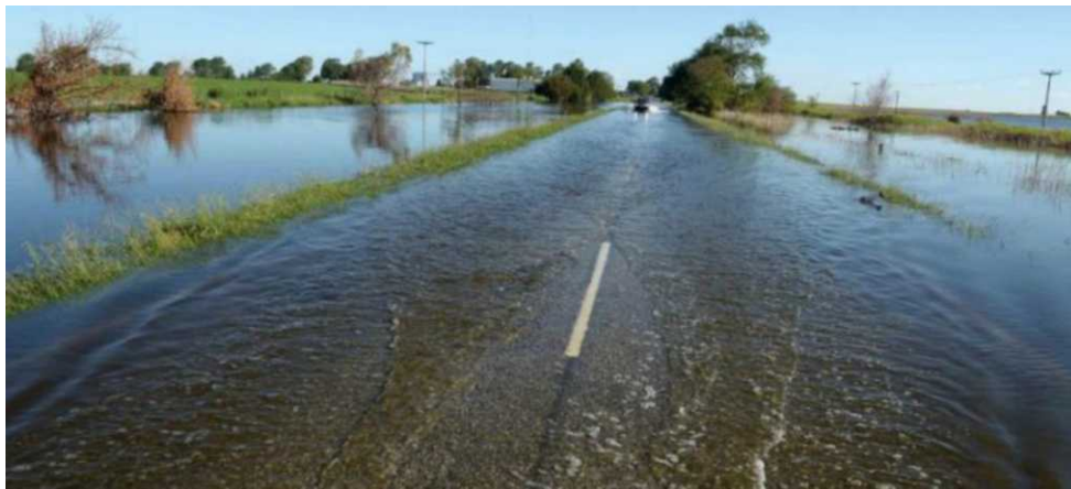
Figura 7. Corte de la RN 9, tramo Rosario-Córdoba, a la altura de Río Carcarañá
