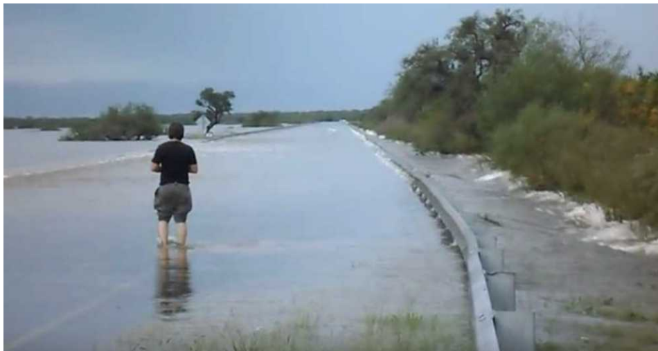
Figura 5. RN12, en proximidades del nuevo puente sobre el A° Feliciano.
