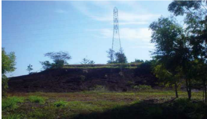
Figura 4. Vista geral da área mostrando o corte de 8,60 m de espessura.
