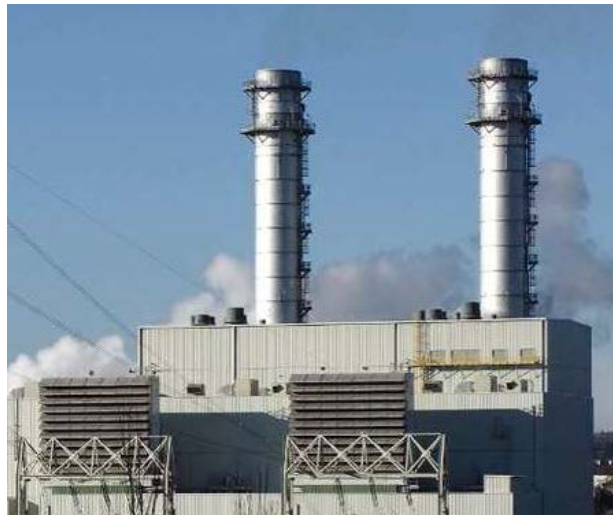
Ilustración 5: Chimeneas CTCC de As Pontes
