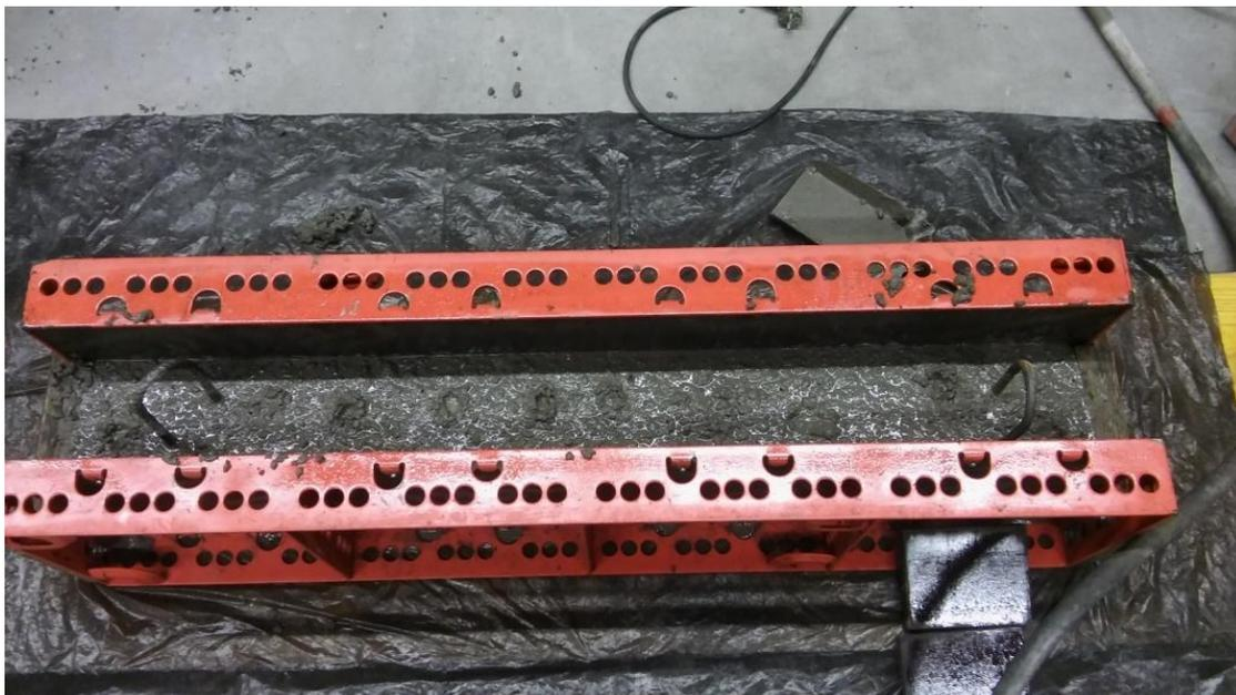
*Figura 6.2.4.4.1. Viga después de vibrado.*
