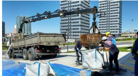
Figura 93: Recepción de cenizas de fondo de la central 1
