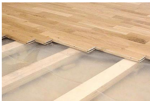
Figura 30. Colocación de parquet. Fuente: www.decoparquet.com
