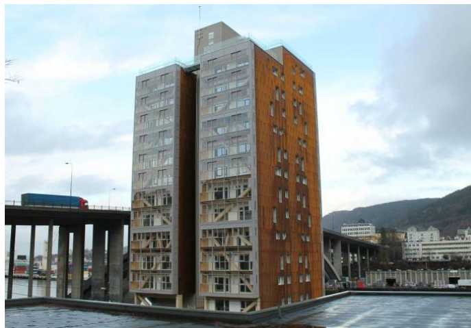
Figura 25. Treet. Edificio de 14 plantas en Bergen (Noruega) es de momento el más alto del mundo. Fuente: www.construible.es (2017)
