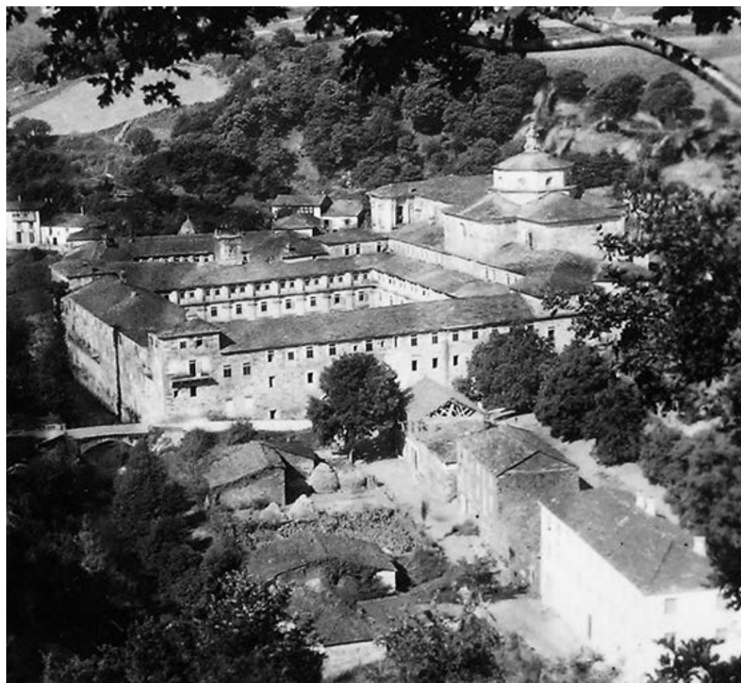
FIG. 12 Área norte del monasterio de Samos en la primera mitad del siglo XX, con una serie de construcciones, cuya disposición es heredera de las antiguas edificaciones monacales que existían dentro del Cercado: las antiguas casas de caballerizas y casas de talleres Fondo Fotográfico del Monasterio de Samos
