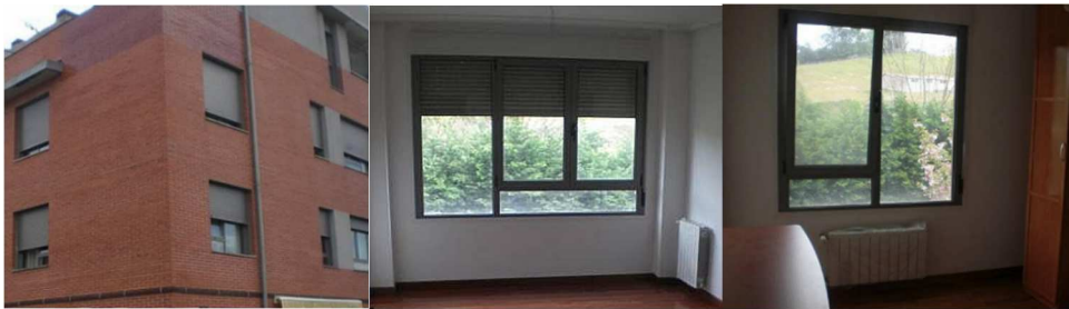
Fig.52: Imagen de la fachada, estancia 1 y estancia 2 de la vivienda en las que se realiza la medición
