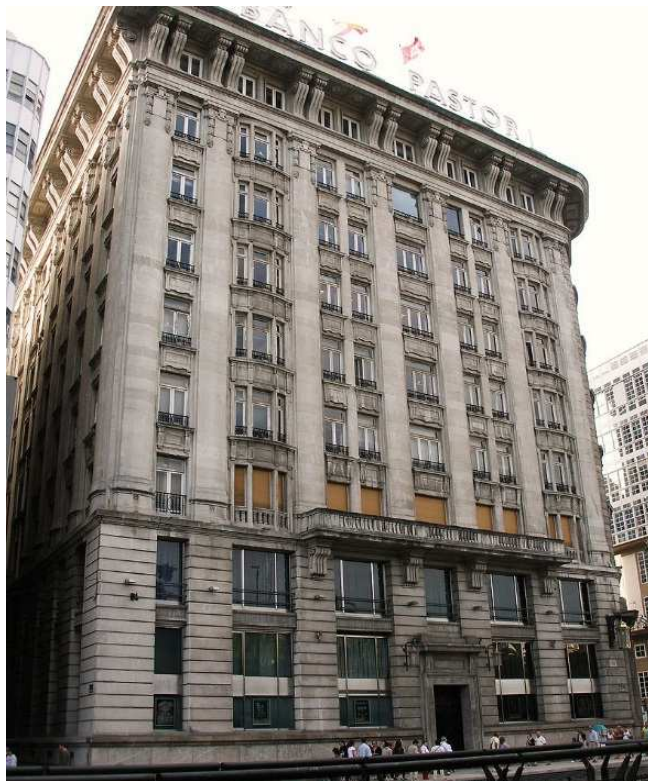
Fig 22 .- Fachada edificio sede del Banco Pastor (proyectado por los arquitectos D. Antonio Tenreiro Rodríguez y D. Peregrín Estellés) fue construido en 1922 y el edificio más alto de España hasta 1929.
