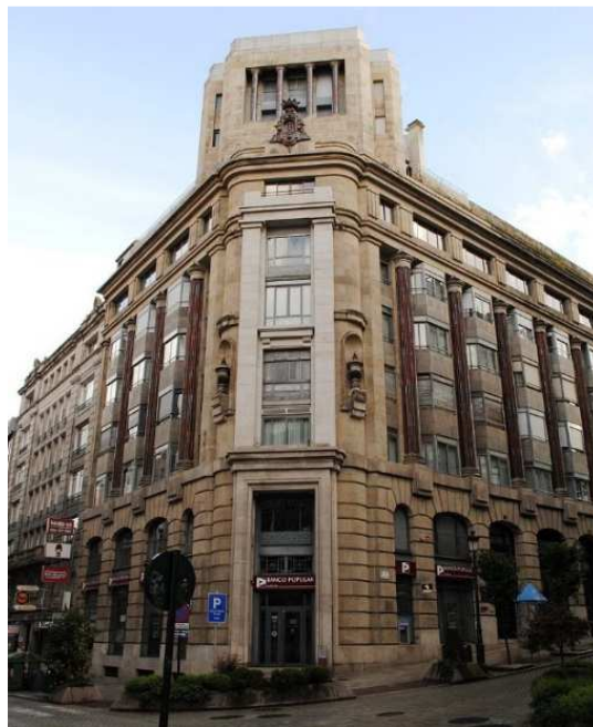
Fig. 23.- Edificio sede Banca Viñas Aranda (proyectado por el arquitecto D. Antonio Palacios Ramilo) situado en la rúa Reconquista esquina Marqués de Valladares, ayuntamiento de Vigo (Pontevedra) finalizada su construcción en 1944.
