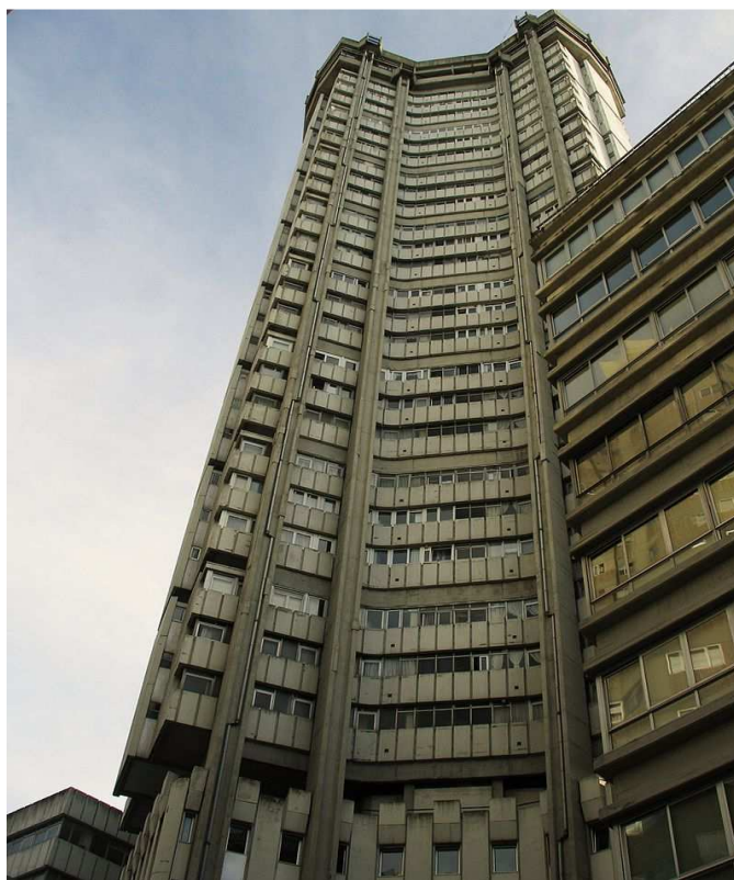
Fig. 25.- Torre HERCON (calle Costa Rica, A Coruña) con 119 m de altura (proyectada por el arquitecto D. José Antonio Franco Taboada) fue construido desde el 1973 hasta 1975
