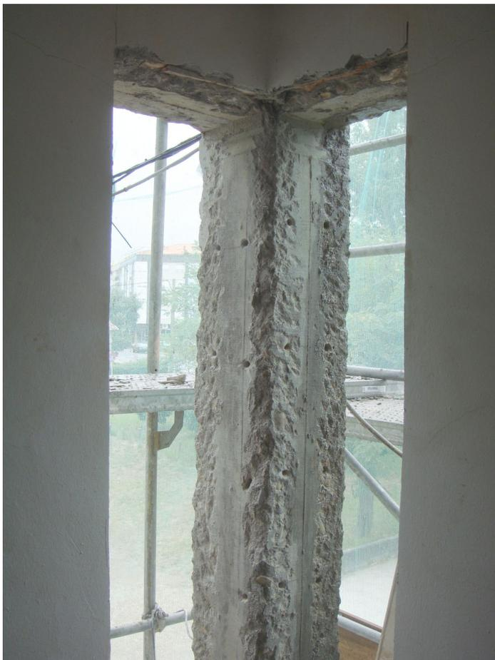
**Figura 9. Preparación del refuerzo del pilar de esquina**
