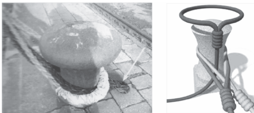
Figura 18. Estachas amarradas incorrectamente. Fonte: VERVLOESEM, W. (2009) Mooring and Anchoring Ships. Vol. 2: Inspection and Maintenance . Londres, Nautical Institute.
