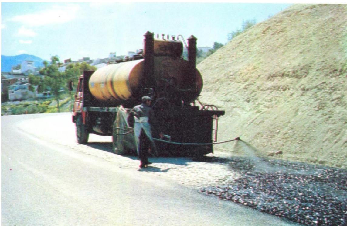
**Figura 5. Ejecución de un macadam por penetración. (Fuente: Bardesi Orue-Echevarría, 1992).**
