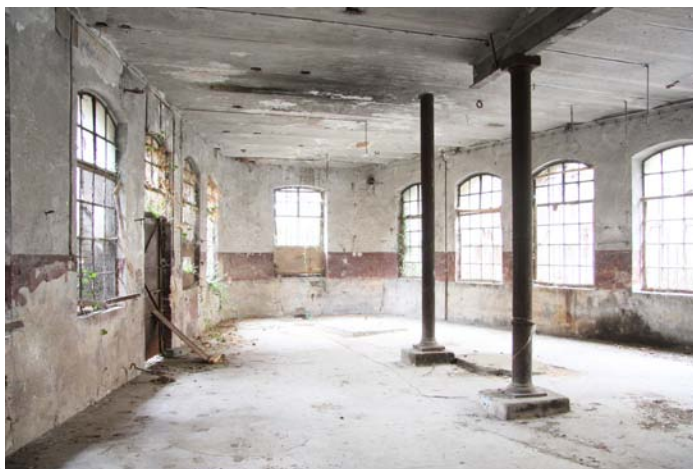
Interior de la f brica. Espace int rieur de l'Usine. Innenraum der Fabrik.
