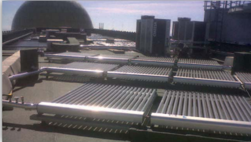
Ilustración 19: Campo colectores térmicos de tubos de vacío. Fuente: SALVADOR ESCODA
