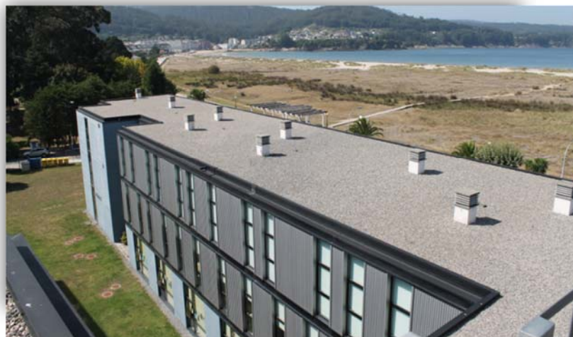
Ilustración 58: Detalle de la cubierta Norte. Edificio en Viveiro. Fuente: Elaboración propia.
