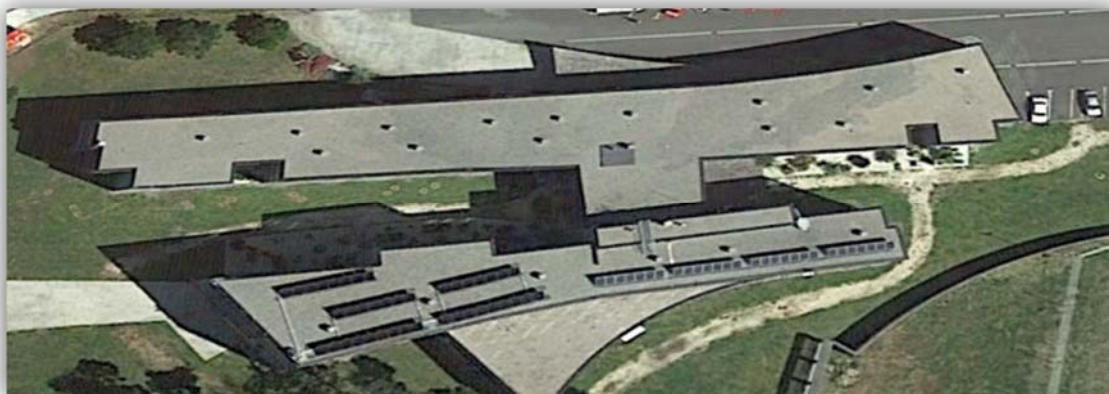
Ilustración 74: Detalle de cubiertas. Edificio en Viveiro Fuente: Google Earth.
