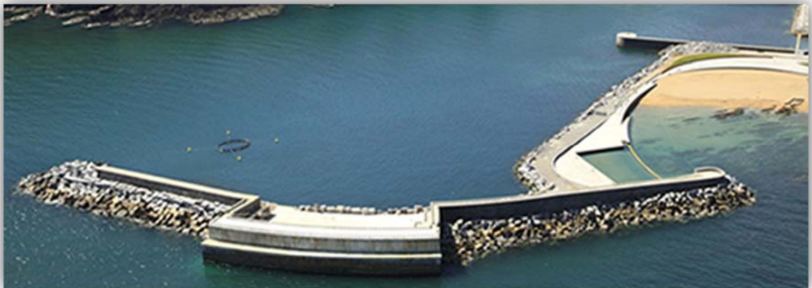
Ilustración 36: Dispositivo de Columna de Agua Oscilante. Mutriku. Fuente: Ente Vasco de la Energía.
