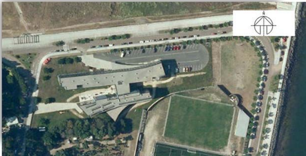
Ilustración 50: Detalle del edificio y parcela (Viveiro). Fuente: Instituto de Estudios do Territorio.
