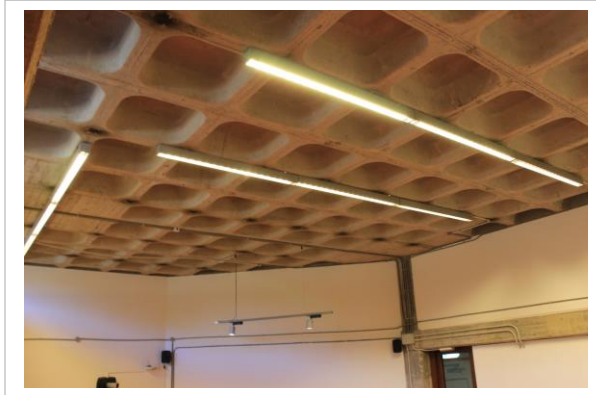
Ilustración 22: techo aulas especiales. Fuente: propia.
