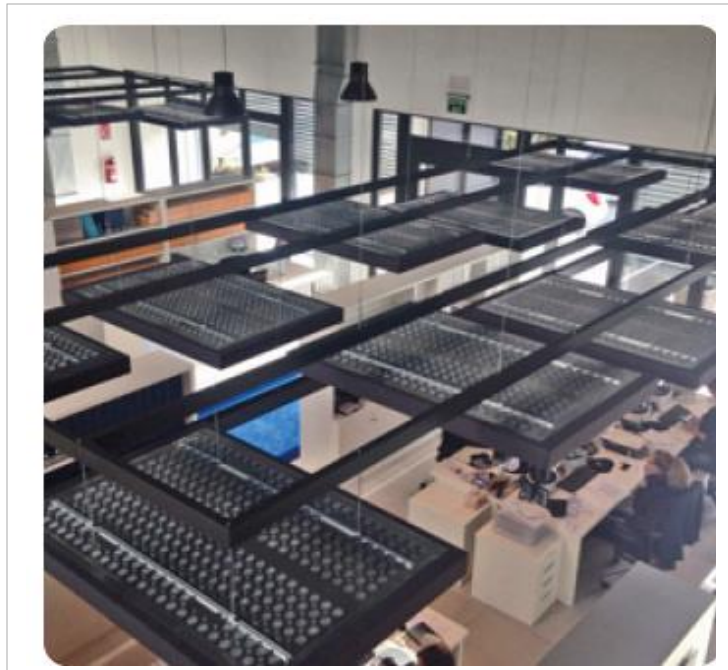
Ilustración 68: ejemplo de paneles suspendidos de techo. Fuente: acústica integral.
