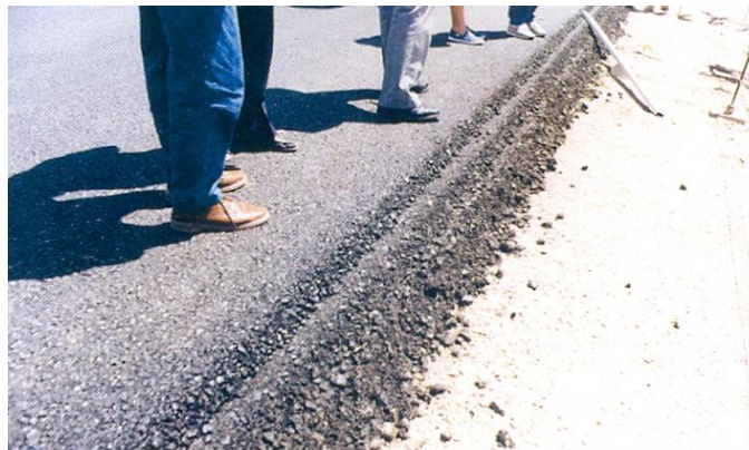
Zahorra bien colocada bajo mezcla bituminosa, en un firme semiflexible
