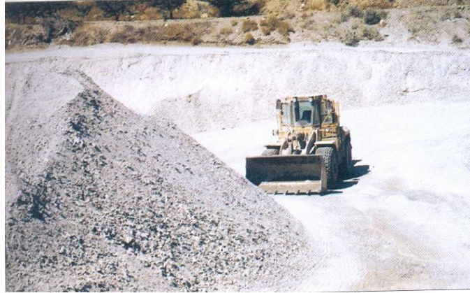
Acopio cónico. Es preferible acopiar por tongadas para evitar la segregación
