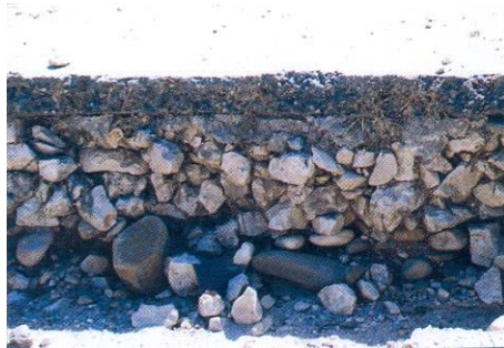
Zahorra en base de firme flexible
