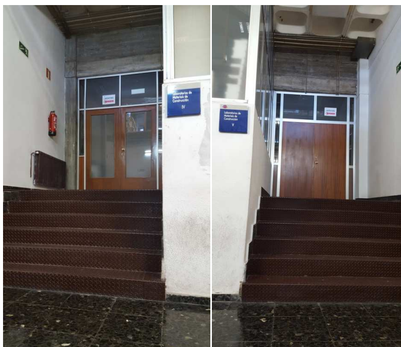
15. Escaleras de acceso a laboratorios IV y V. Fuente: Autor.
