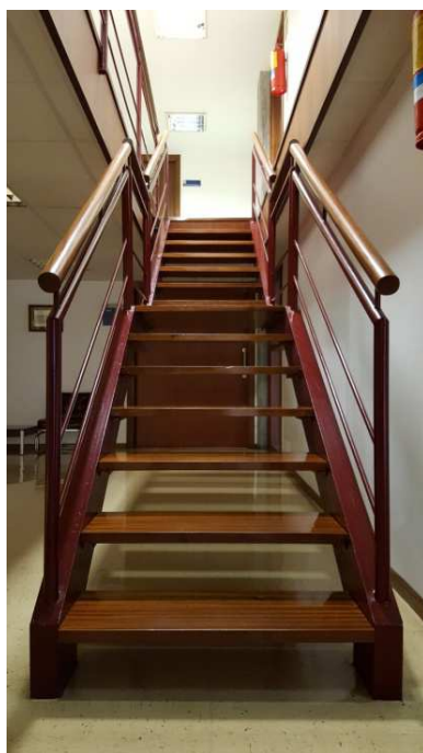
27. Tramo de escaleras acceso despachos altos de construcción. Fuente: Autor.
