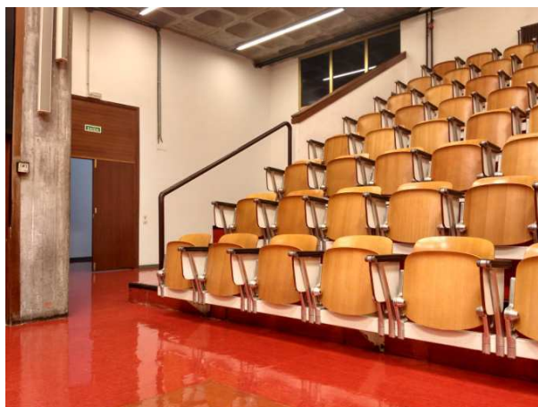
30. Estrechamiento puntual en pasillo de entrada a Aula Magna. Fuente: Autor.
