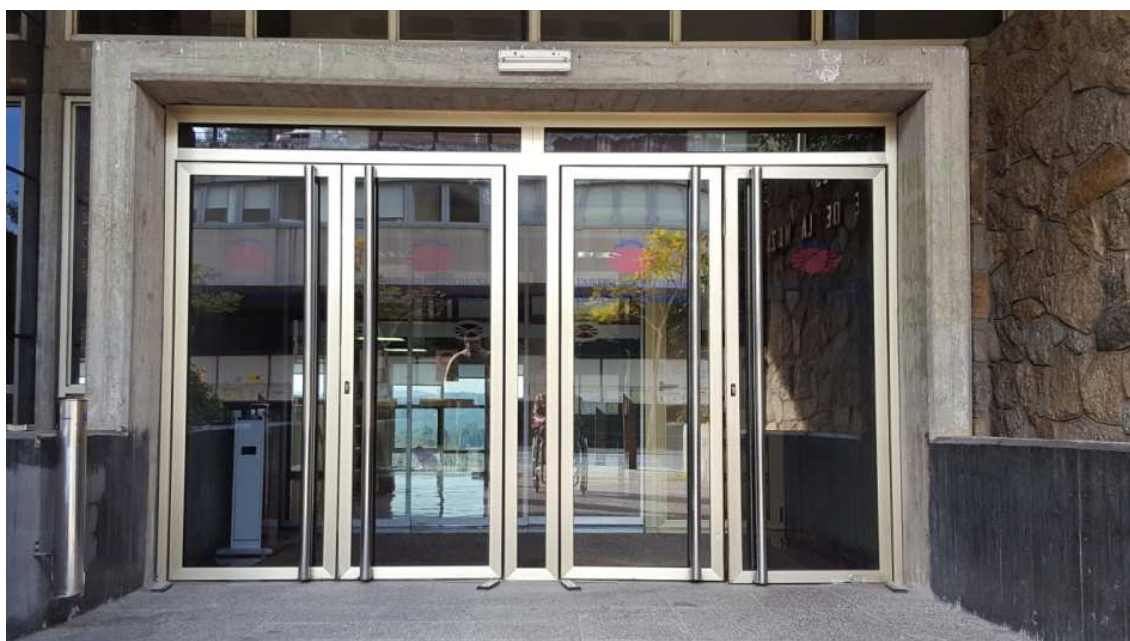
22. Puertas de entrada acceso 1 de fachada S.E. Fuente: Autor.
