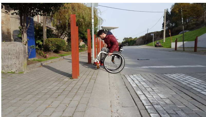
26. Escalón existente en paso peatones acceso 1. Fuente: Autor.
