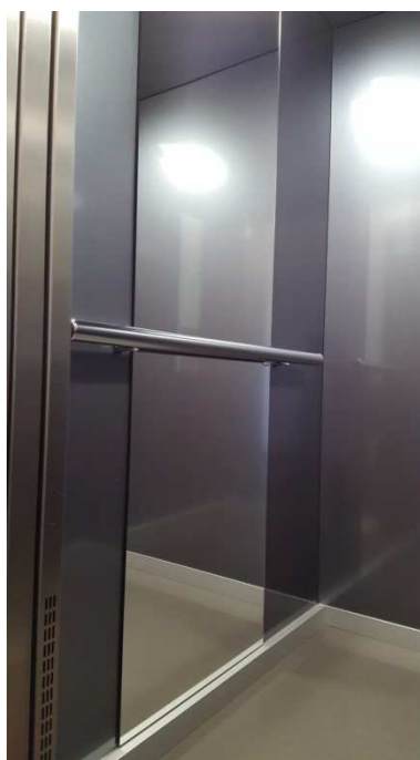
12. Barra para asir interior ascensor secundario. Fuente: Autor.
