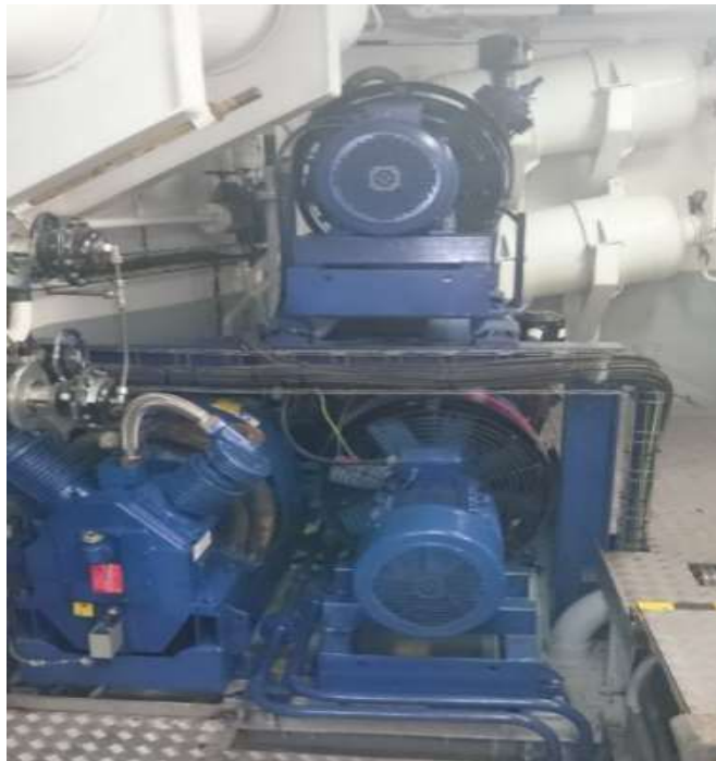
Ilustración 50 Compresores de Aire P.A
