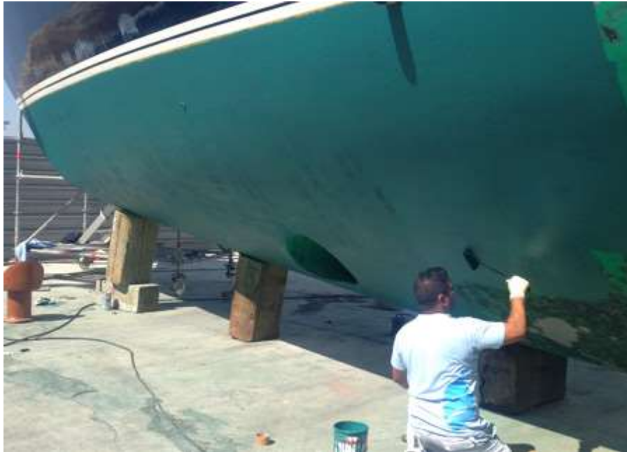
Ilustración 31 Operario pintando el casco del buque
