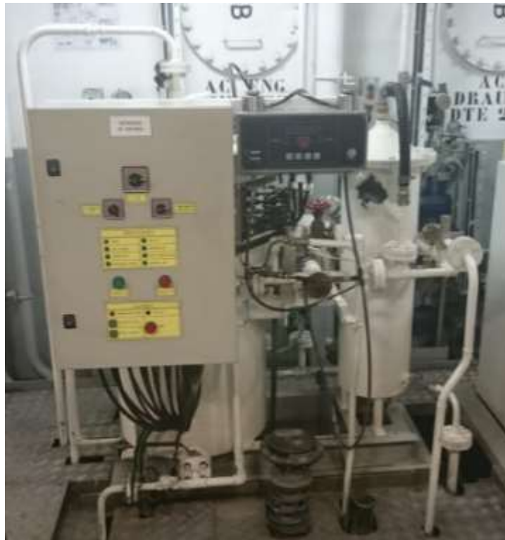
Ilustración 45 Separador de Sentinas (P.A)
