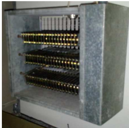
Figura 7.3.1 – Recalentador UTA.
