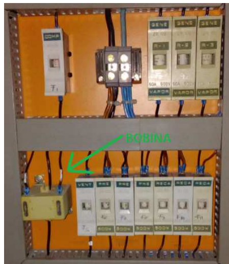
Figura – Situación de la bobina en el cuadro de la UTA.
