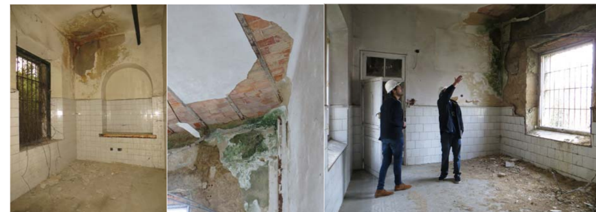
05. hongos en los encuentros con los muros exteriores
