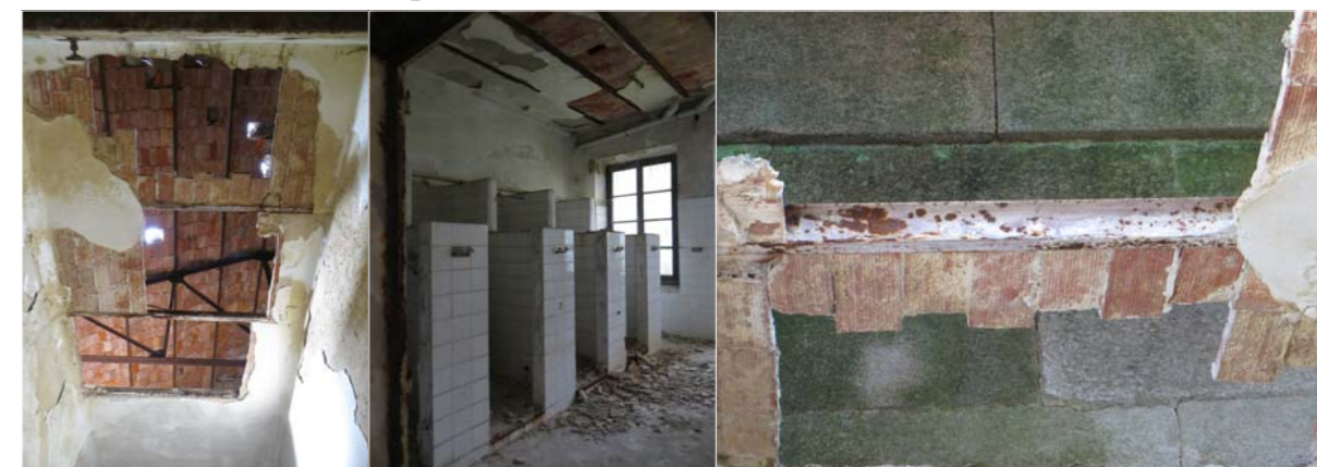
05. hongos en los encuentros con los muros exteriores
