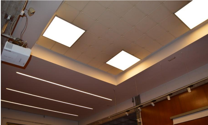
Figura 14. Vista de los distintos tipos de techo de la escuela universitaria de arquitectura técnica. Fuente propia.
