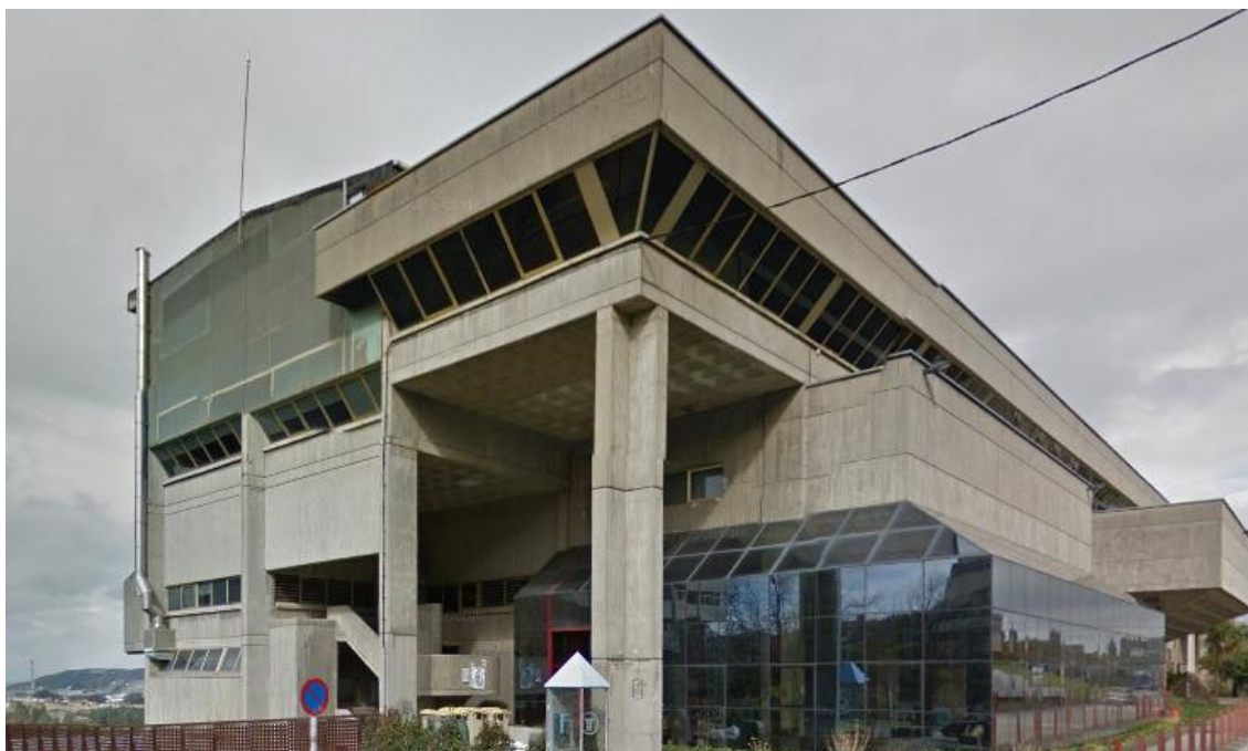
Figura 11. Vista de la escuela universitaria de arquitectura técnica. Fuente propia.
