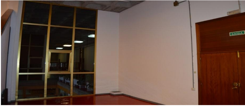
Figura 15. Vista de los paramentos en donde se encuentra una ventana y una puerta del aula magna de la escuela universitaria de arquitectura técnica. Fuente propia.
