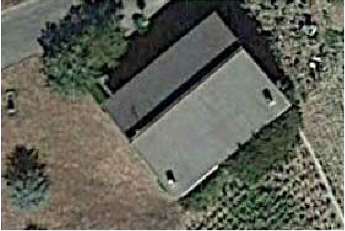
FOTO ÁEREA DE LA CUBIERTA
