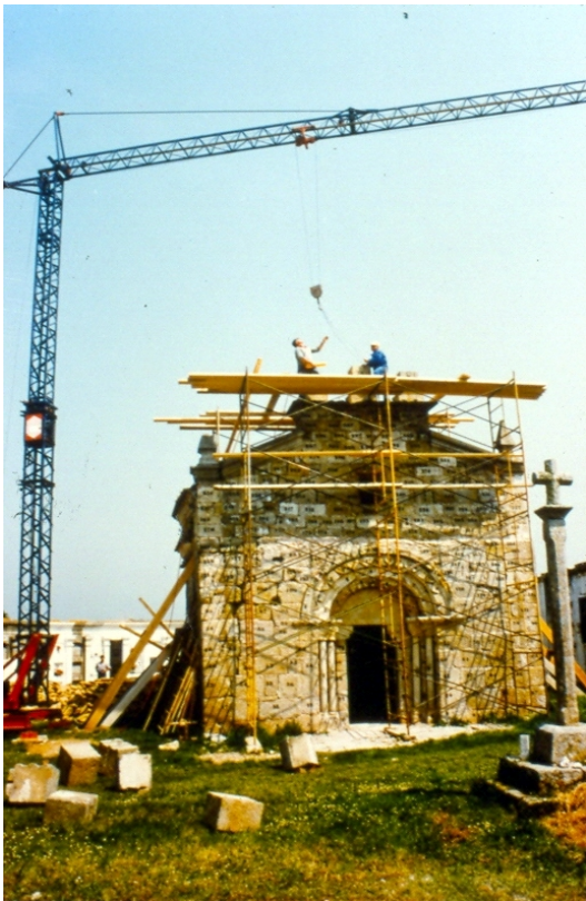
8.- Numeración de los sillares para desmontar la fachada (foto JRS)
