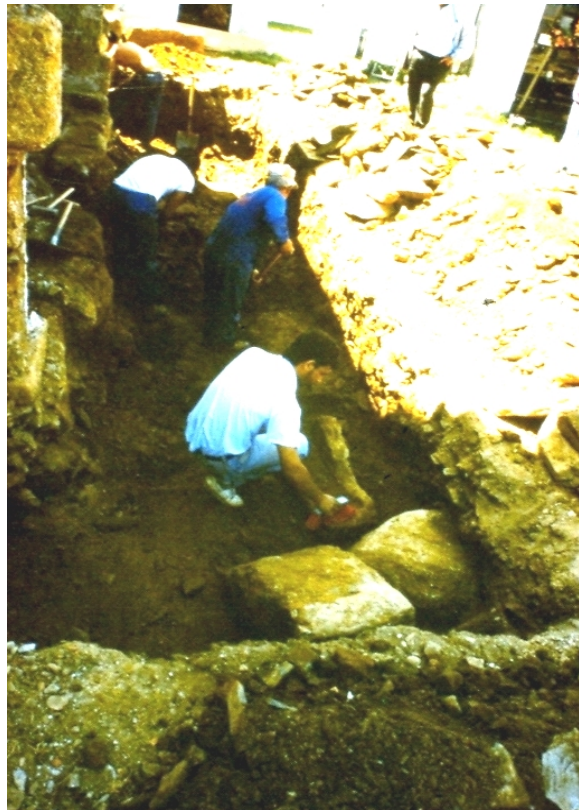
8.- Numeración de los sillares para desmontar la fachada (foto JRS)
