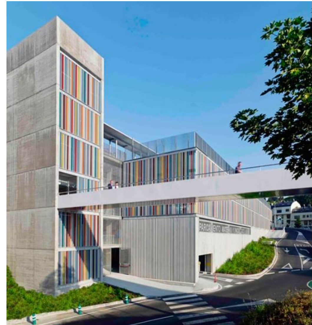
Figura 7. Pasarela metálica peatonal del hospital Materno y Oncológico de A Coruña. Fuente: diazydiazarquitectos.com
