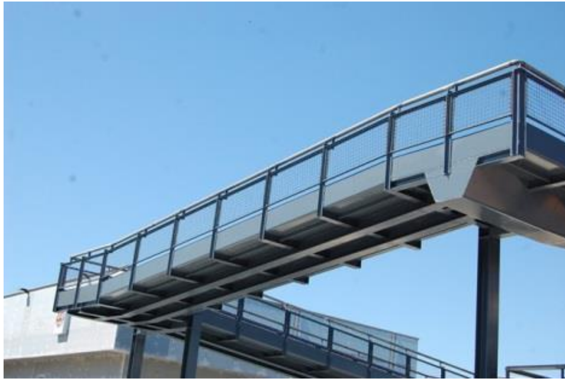
Figura 8. Pasarela metálica peatonal en Madrid. Fuente: alguazas.es
