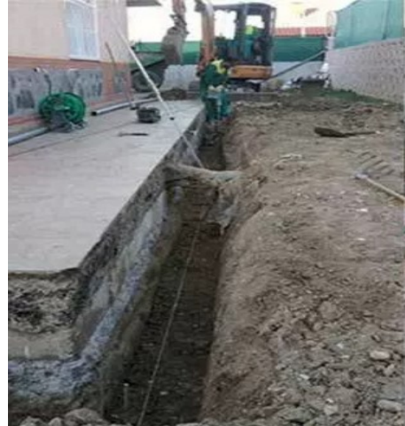
Ilustración 18: Ejecución de drenaje en el extradós de un muro, fuente: www.tusreformasbaratas.com
