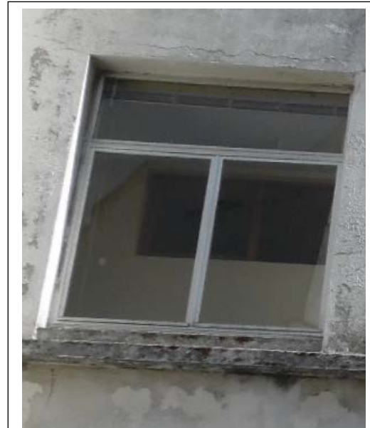
Ilustración 62: Incorrecto remate de jambas, vierteaguas y goterón de ventana
