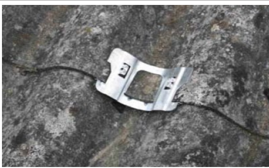
Ilustración 163: Anclaje a plancha con amianto, fuente: http://www.onduline.es
