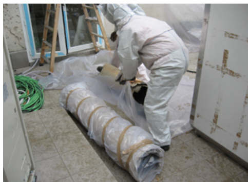
Ilustración 31: Retirada de tubería con amianto, fuente: www.voladurasydemoliciones.es
