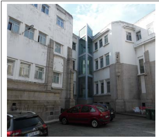
Ilustración 98: Ascensor desde exterior
