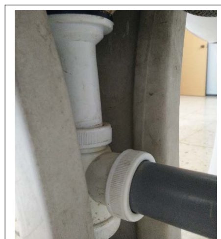
Ilustración 73: Desagüe ejecutado correctamente
