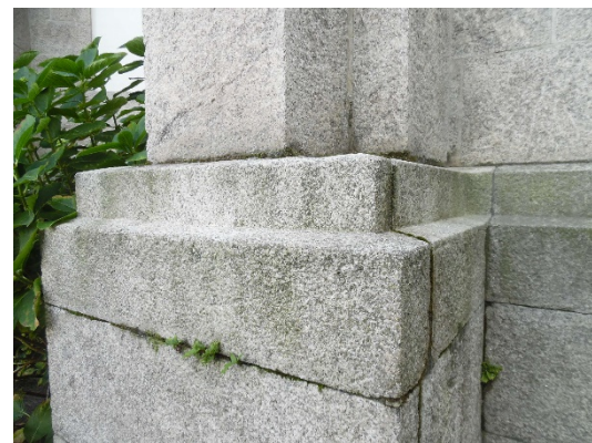
Ilustración 65: Crecimiento de vegetación en juntas
