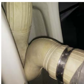
Ilustración 129: Sifón aplastado
