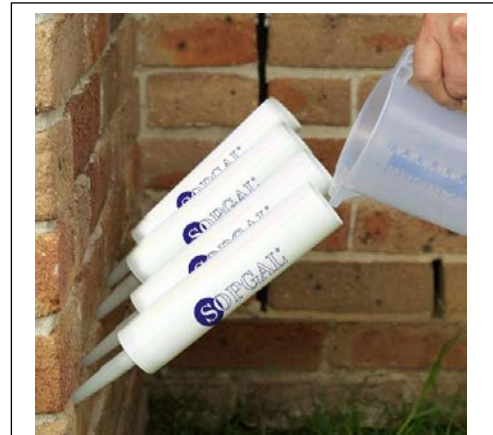
Ilustración 22: Inyección de hidrofugante en muro fuente: antihumedades.es
