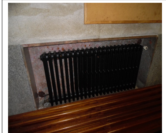
Ilustración 125: Radiador de hierro pintado en oscuro para el aprovechamiento del calor.
