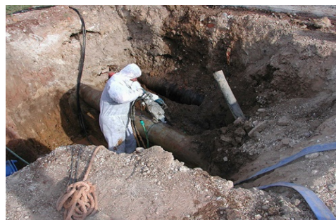
Ilustración 36: Corte de tubería con amianto, fuente: www.empleo.gob.es
