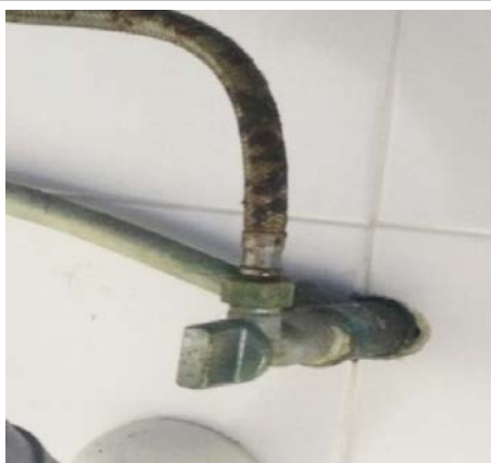
Ilustración 134: Latiguillo desgastado
