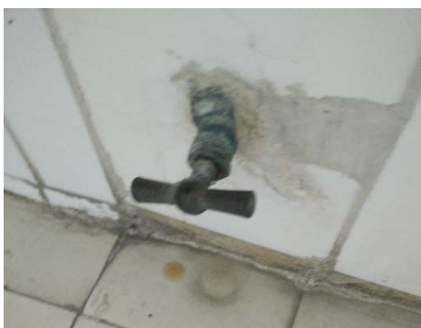
Ilustración 135: Llave de corte ineficiente
