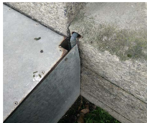
Ilustración 105: Entrada de gas a la edificación
