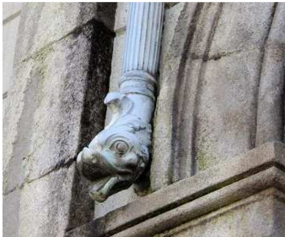
Fotografía 6: Remate de bajantes Fuente: www.vilasamuralladas.eu
