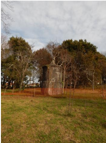
Ilustración 3. Depósito de agua
