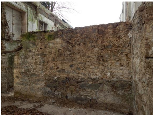
Ilustración 13. Muro de carga interior
