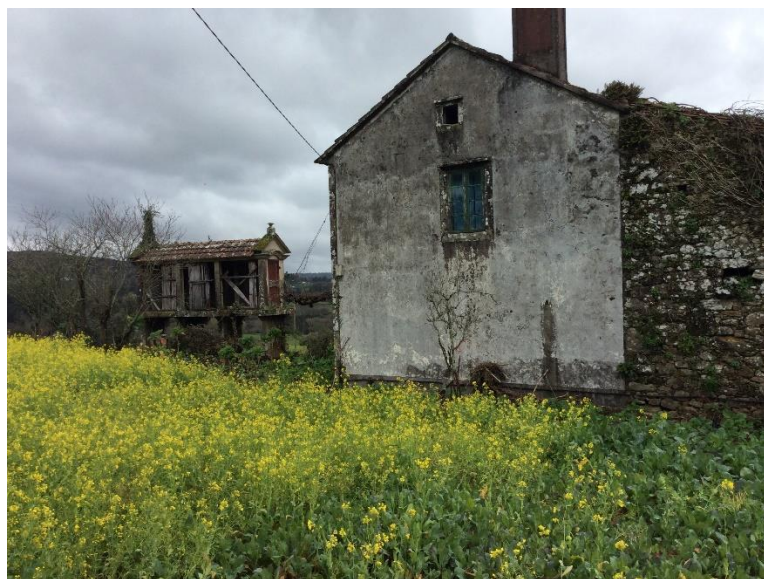
Foto 16. Vista exterior fachada SurEste. (Fuente: Propia)
