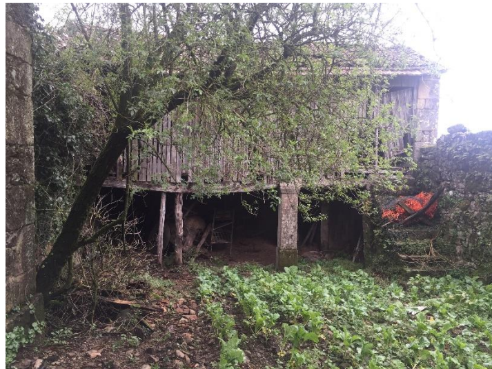
Foto 21. Cobertizo anexo desde el patio exterior. (Fuente: Propia)
