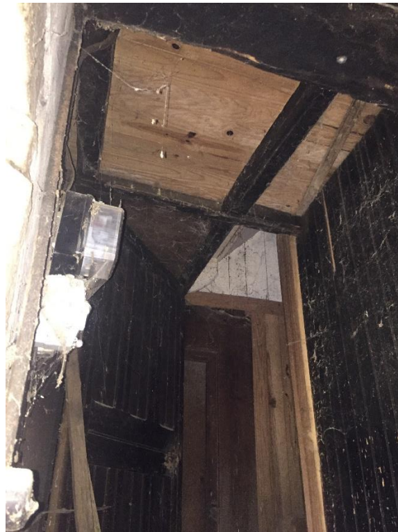
Foto 47. Vista interior de caja de escalera en planta baja. (Fuente: Propia)
