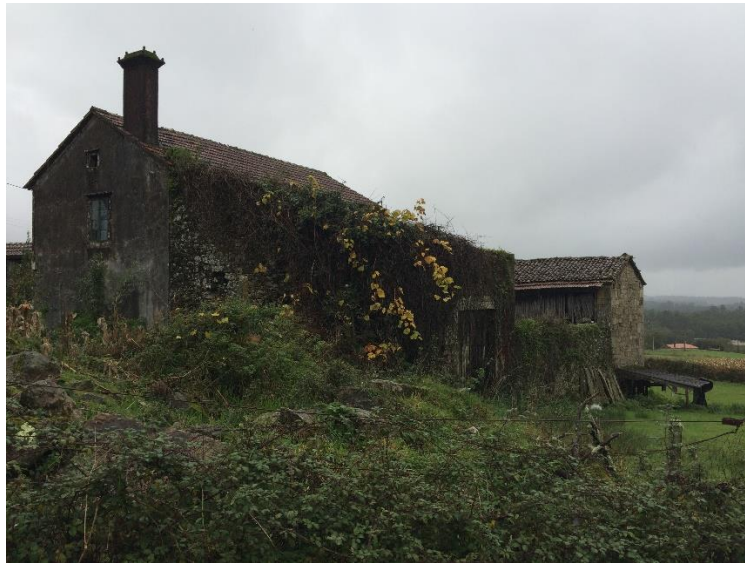
Foto 15. Vista exterior desde carretera de acceso. (Fuente: Propia)
