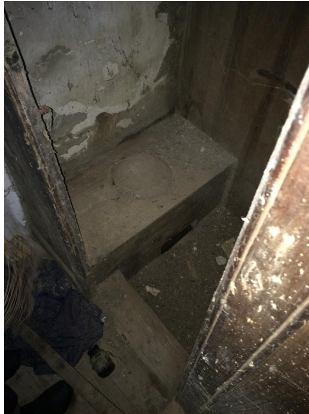
Foto 33. Vista interior del aseo original en la planta baja. (Fuente: Propia)
