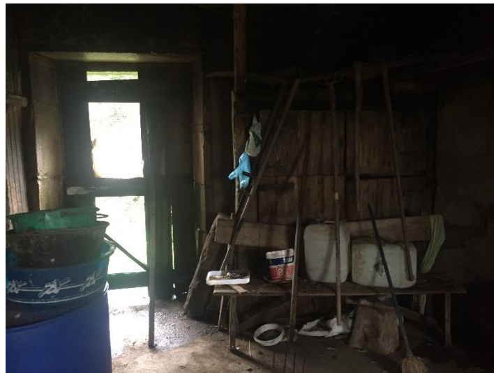
Foto 29. Vista interior de la planta baja. (Fuente: Propia)
