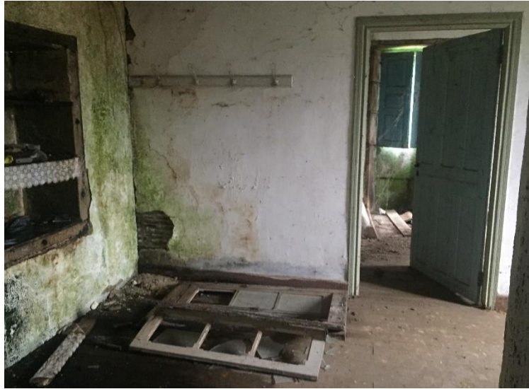
Foto 37. Vista interior del comedor en planta alta. (Fuente: Propia)
