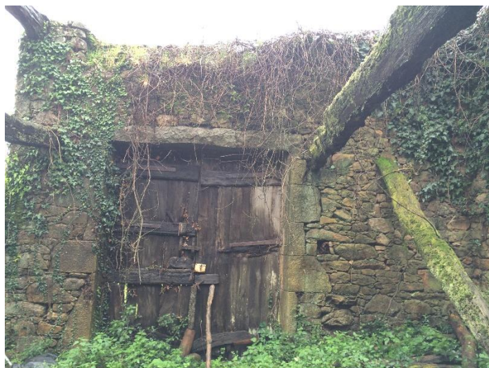
Foto 25. Vista desde el patio exterior a la puerta en fachada NorOeste.
