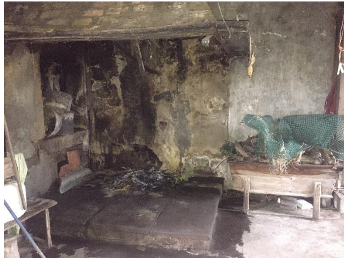
Foto 28. Vista interior de la lareira en planta baja. (Fuente: Propia)
