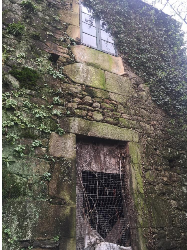
Foto 23. Vista exterior ventanas en fachada NorEste. (Fuente: Propia)
