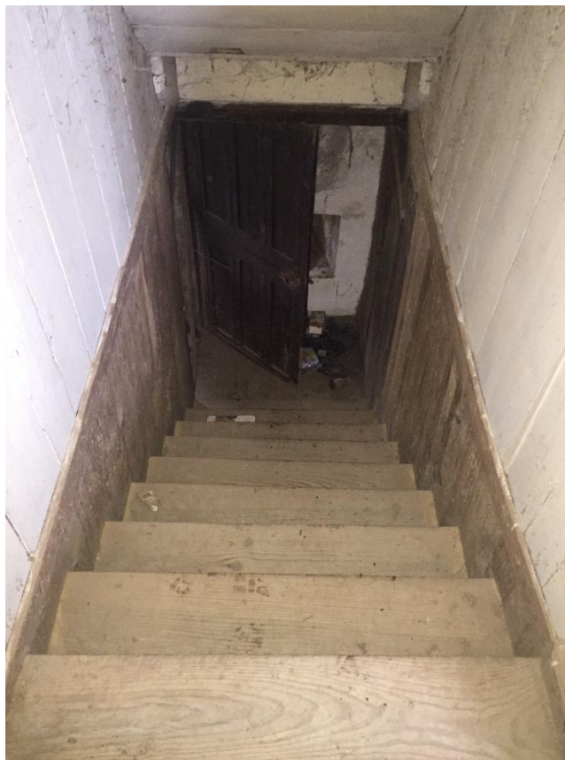
Foto 35. Vista interior de las escaleras. (Fuente: Propia)
