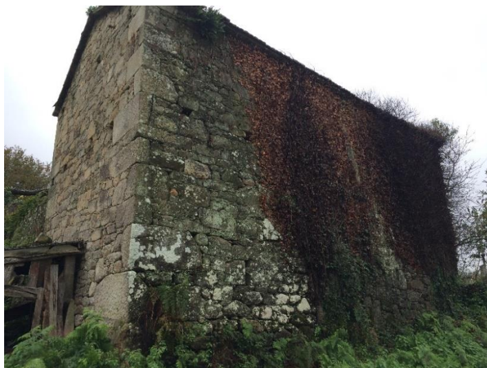
Foto 18. Vista exterior fachada NorOeste. (Fuente: Propia)
