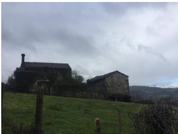
Foto 17. Vista exterior fachada NorOeste. (Fuente: Propia)
