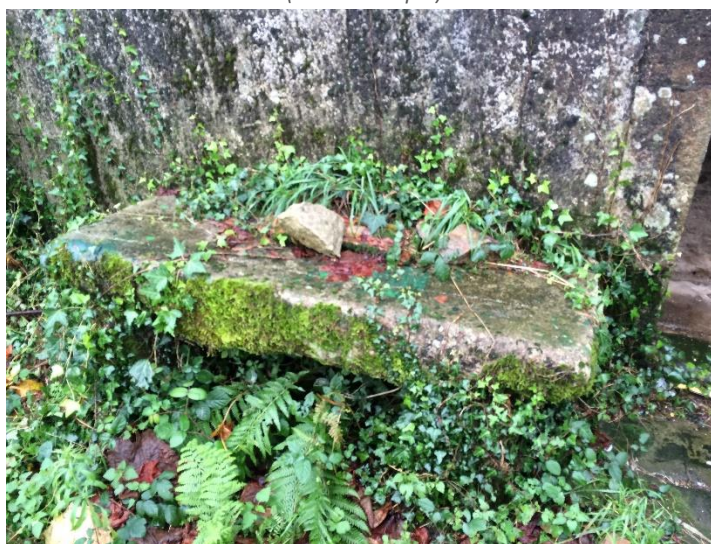
Foto 26. Banco en la fachada principal SurEste.
