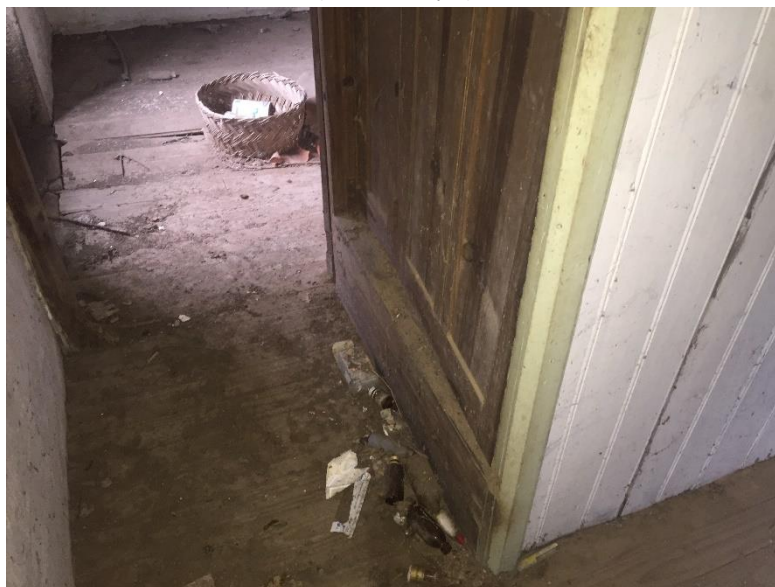
Foto 43. Vista interior de acceso a escaleras a planta bajo cubierta. (Fuente: Propia)
