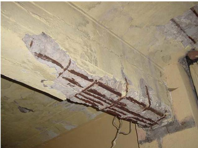
Imagen 3.4 Corrosión de las armaduras
