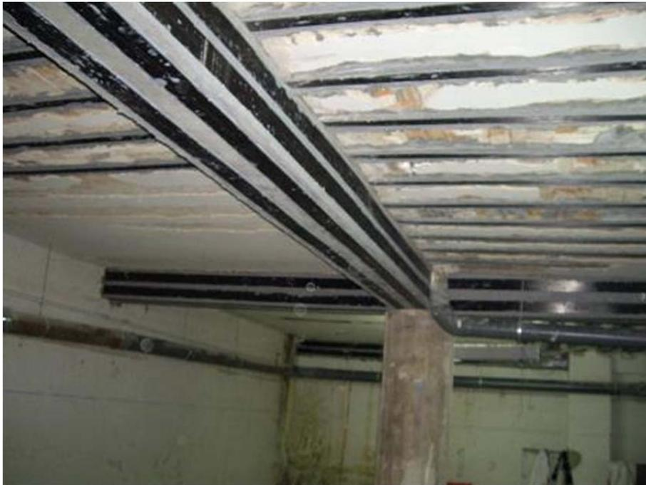
**Imagen 3.2 Refuerzo estructural con bandas de fibra de carbono**
