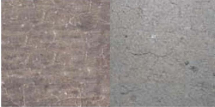
Imagen 3.3 Fisuración del hormigón (en “mapa” o en “piel de cocodrilo”)
