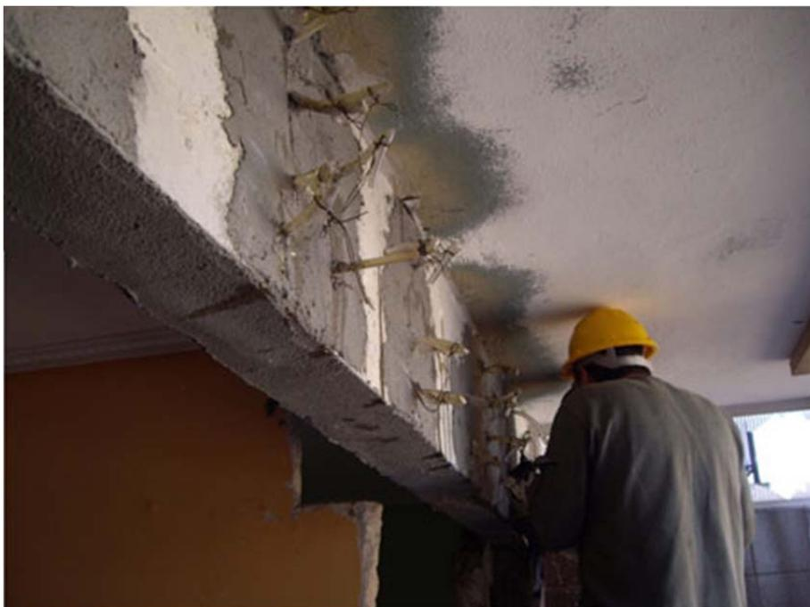
Imagen 3.1 Reparación de las estructuras de hormigón
