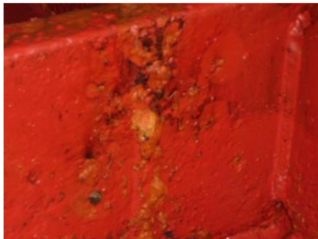
Imagen 5.6. Imagen del tanque mostrando que la mayor parte de oxidaciones y corrosiones se encuentran en zonas de refuerzos y partes bajas.
