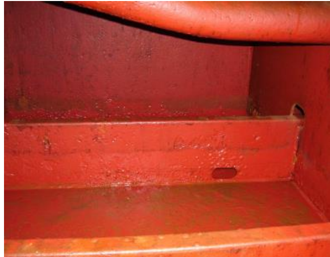
Imagen 5.9. Ampollas dispersas por todo el tanque en un 15%.
