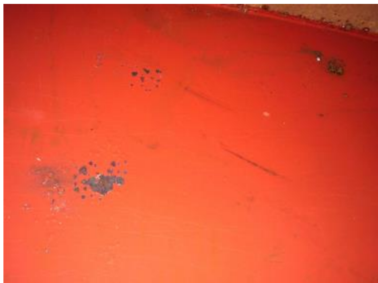
Imagen 5.12. Imagen del interior del tanque nº1 profundo estribor.
