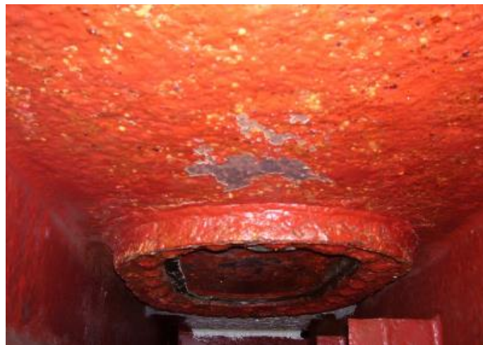
Imagen 5.11. Imagen del interior del tanque n°2 doble fondo babor.
