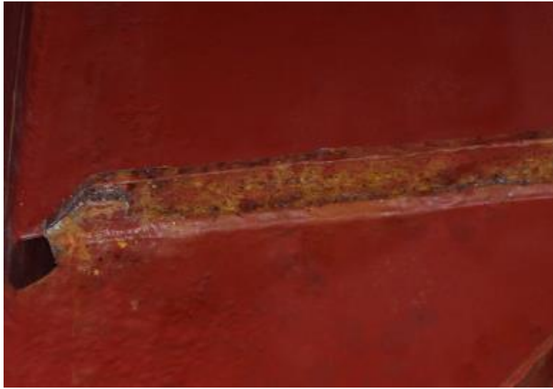
Imagen 5.16. Oxidaciones en los mamparos del tanque nº2 profundo babor.
