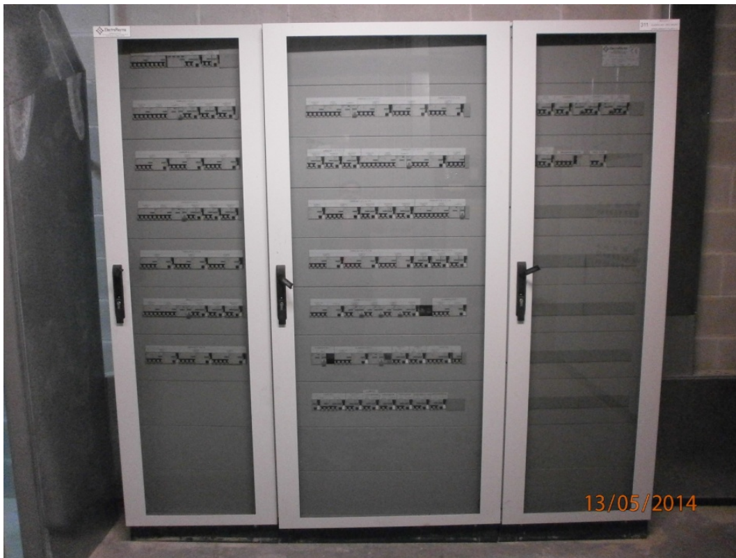
Imagen 4.2.1.1. cuadro principal Red/Grupo N1 Sótano 1
