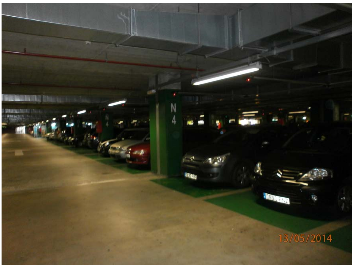
Imagen 4.2.2.1. Carril iluminado en parking
