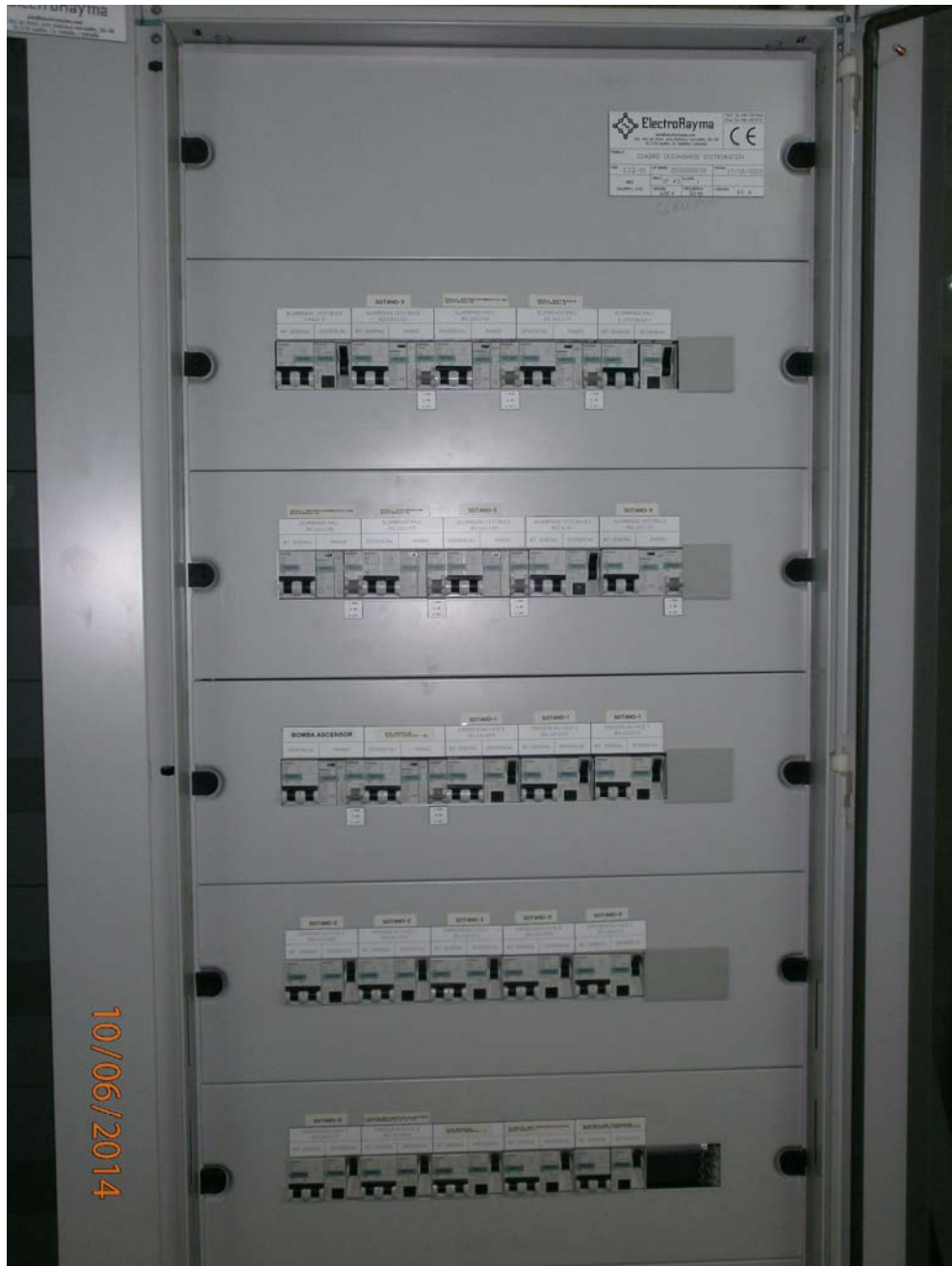
Imagen 4.3.1.1.1 cuadro principal SAS 1
