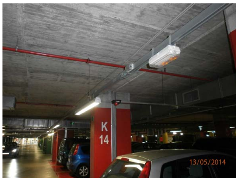
Ilustración. 4.2.1. Alumbrado de parking.
