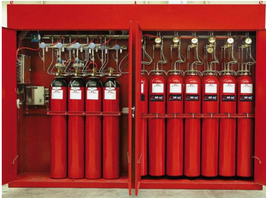
Figura 1.7.2.1 – Almacenamiento de CO 2 a alta presión
