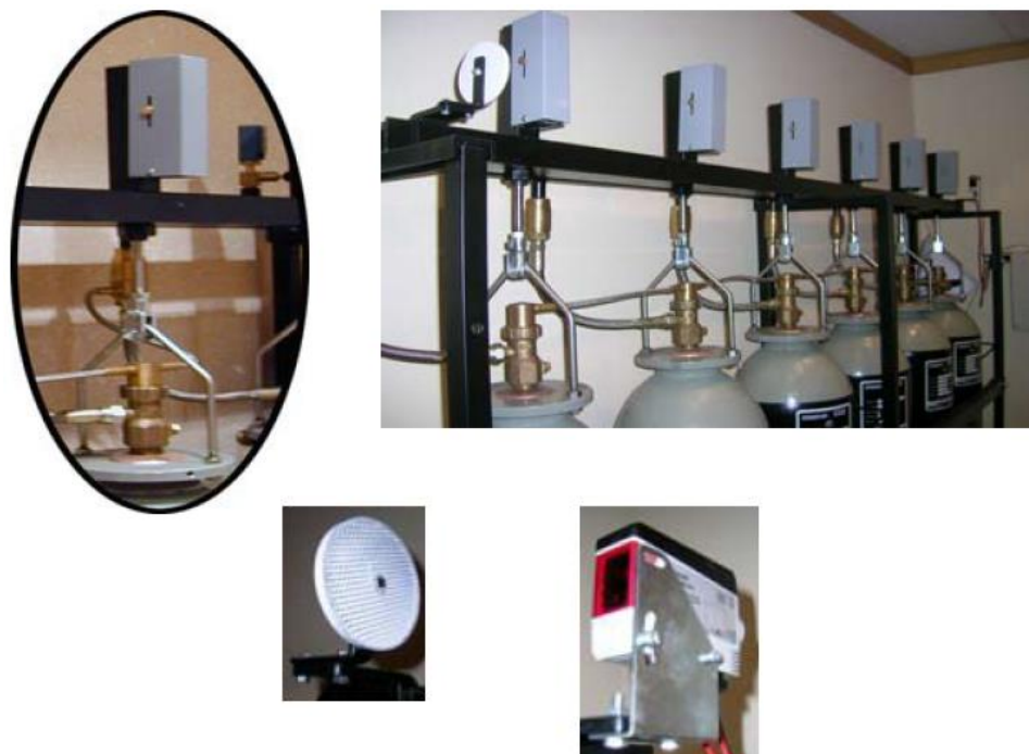
Figura 1.7.5.3.2 – Sistema mecánico con detector fotoeléctrico
